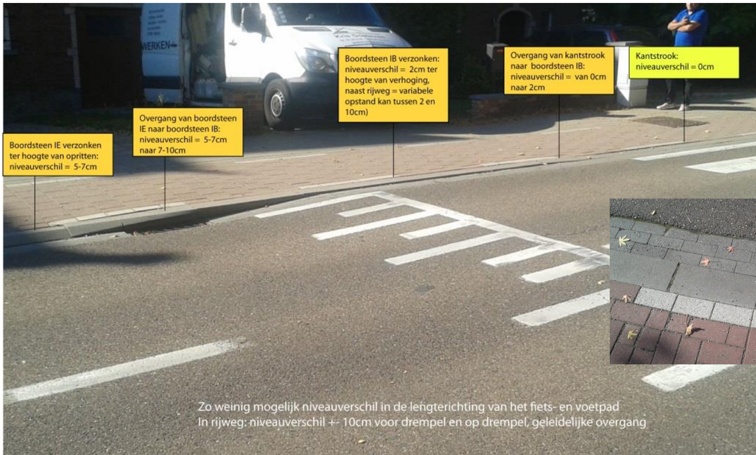
Verhoogd kruispunt met ter hoogte van het zebrapad 0 cm niveauverschil
