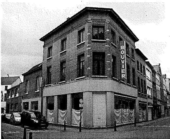
Bestaande toestand vóór renovatie
