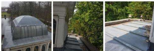
Het noordwestelijke gedeelte (5) heeft een zinken schilddak met felsnaden en centraal een opengewerkte lantaarn met een bollend schilddak in zink en lood. De muurdeklstenen bestaan uit blauwe hardsteen.
