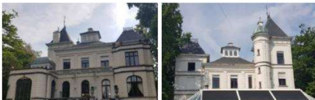
Het hoofdgebouw (3) is afgedekt met een leien schilddak met centraal een opengewerkte lantaarn (zie verder)
