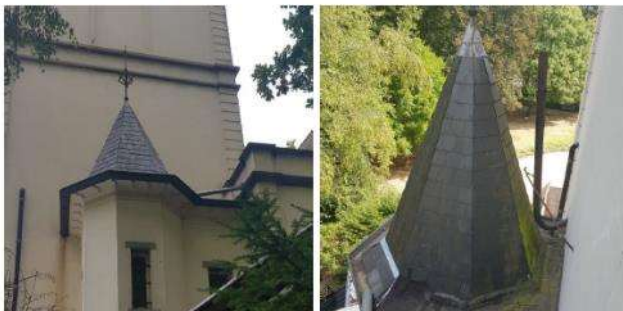
Het aangebouwd achthoekig torentje (12 en 13) aan de noordgevel heeft een leien torendak en is bekroond met een smeedijzeren spits. De verbindingen van de dakvlakken zijn uitgevoerd in zink en roofing.
