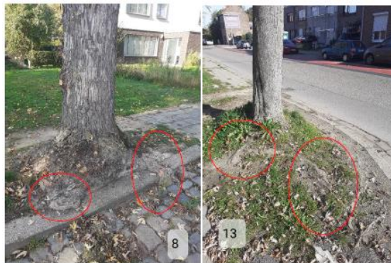
Figuur 5: boom nr. 8 en 13. Idem dezelfde opmerking als bij figuur 4. Oppervlakkige boomwortels zijn reeds beschadigd en/of vergroeid met de boordstenen. Deze inpassen in een nieuwe boomspegel levert schade op.
