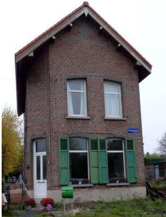
Figuur 5-93 Veewachterswoning en herberg
