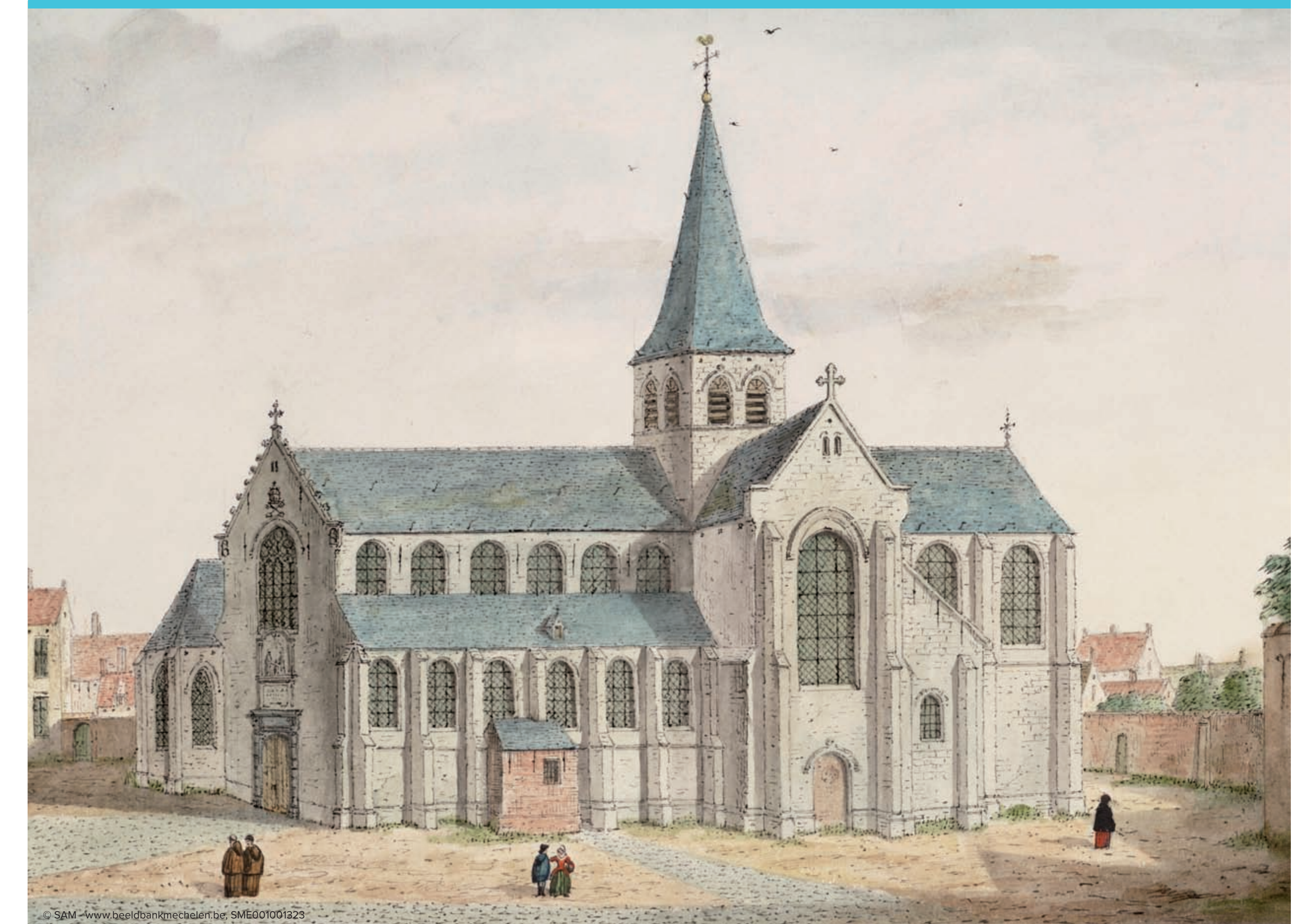
▼ Zicht op de zuidzijde van de Sint-Catharinakerk omstreeks 1790. De 18de-eeuwse segmentboogvensters in de middenbeuk, de oude sacristie en het 17de-eeuwse westportaal zijn nog te zien. De zuidelijke Sint-Antoniuskapel (1833) was nog niet gebouwd. Aquarel toegeschreven aan A.F. Van den Eynde.
