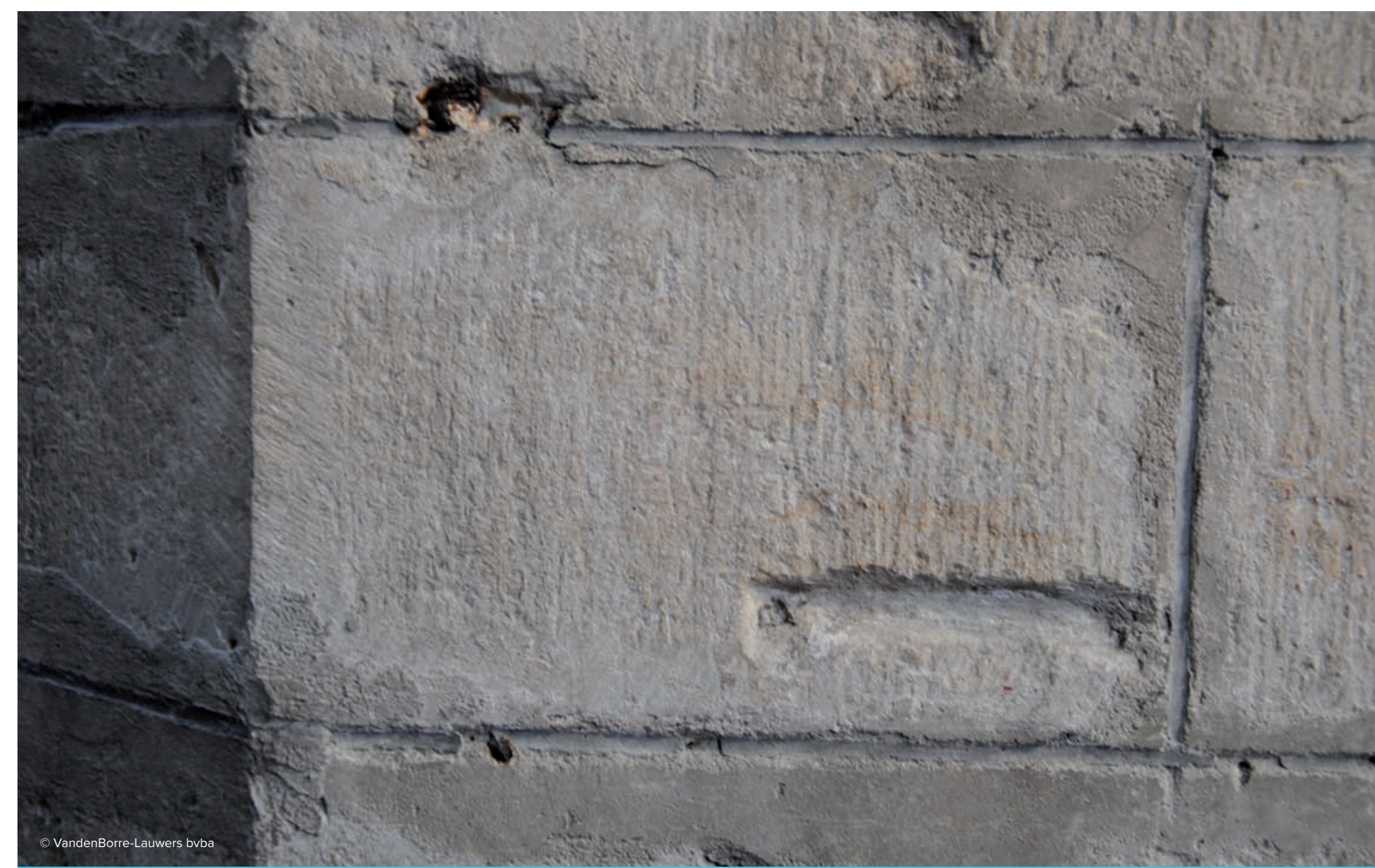
▲ Fase I volgens de stenhouwchronologie van Frans Doperé: 12de eeuw tot ca. 1420: noordoostelijke vieringpijler.
