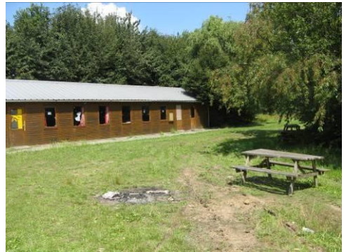
Foto 4: Zicht op noordelijke gebouw
