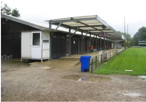
Foto 1: Kantine en omkleedruimten
