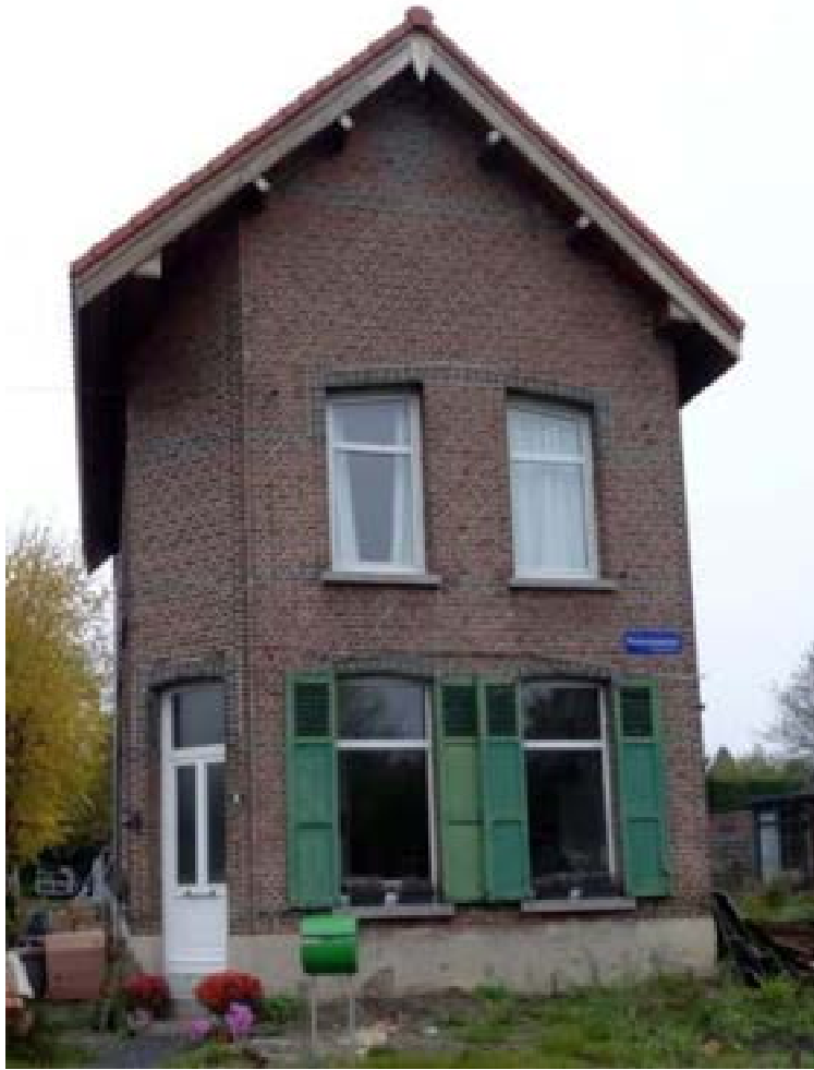
Figuur 5-88 Veewachterswoning en herberg
