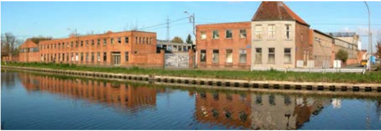
Figuur 3-3: Voormalige fabriek PRB Meralurgia, gesloopt (Bron: http://www.despreeuw.be/boemekot/ )
