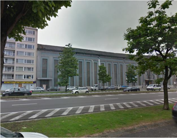
9. Zicht op voormalige gevel Cometgebouw vanaf overzijde Vesten (07/2014)
