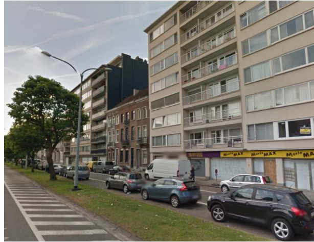
10. Hogere bebouwing langs de vesten (07/2014)
