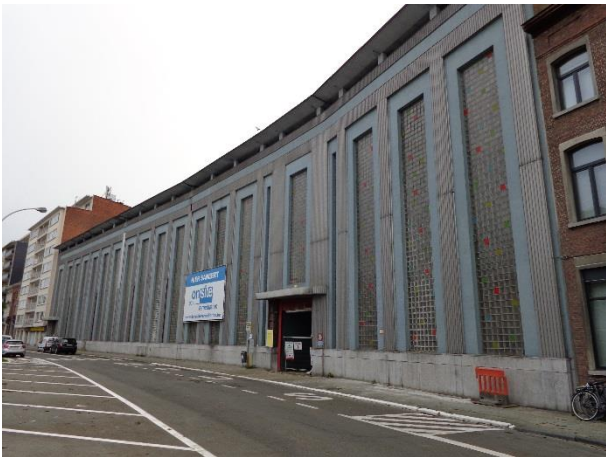
7. Voormalige gevel Cometgebouw (7/11/2014)
