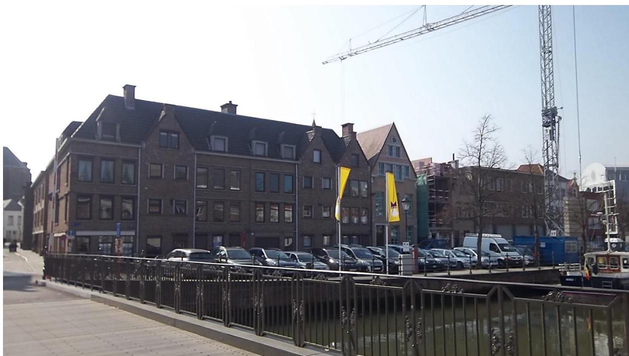
Figuur 1 bouwblok Dijle-Keerbergstraat, zicht vanaf de Dijle (17/03/2015)
