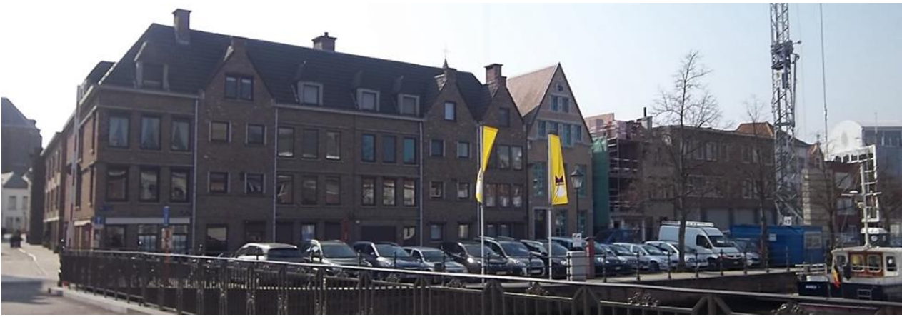
Figuur 1 Bouwblok Dijle-Keerbergstraat, zicht vanaf de Dijle (17/03/2015)
