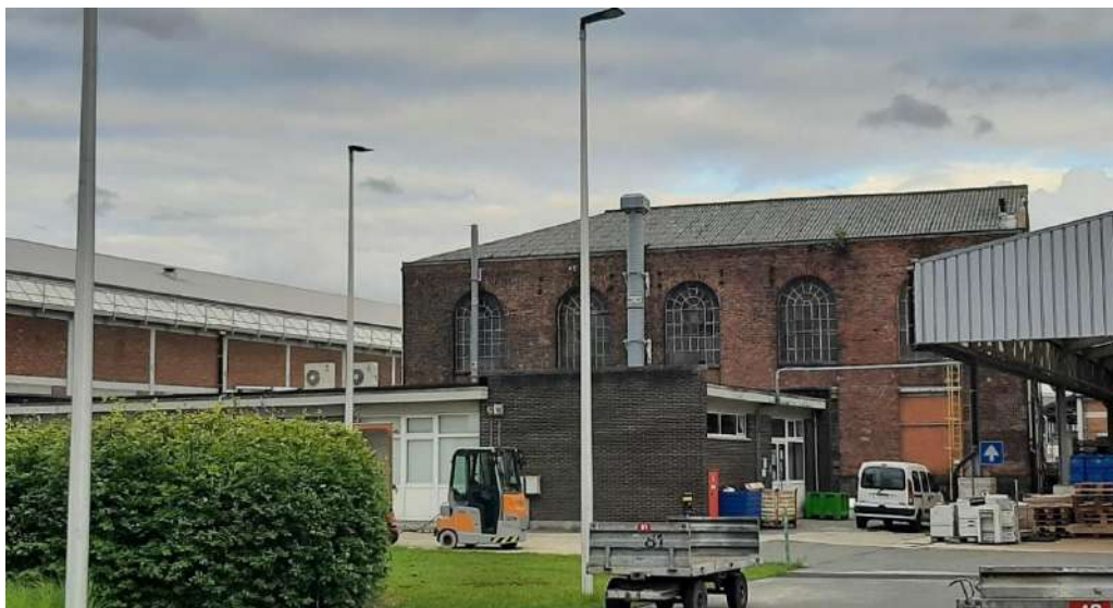
Figuur 5-101 Voormalig laboratorium voor mechanische proeven van 1880-1882 (actuele toestand)
