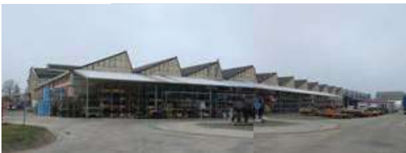
Figuur 280: Foto's bestaande toestand loodsen
