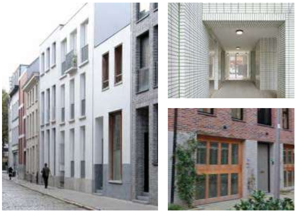
Figuur 243: Referentie plint of gelijkvloerse verdieping solide basis met voldoende hoogte (3.50m tot 4.50m), duidelijke portriek, reliëfrijke gevel, verticale gevelordening ook in geval van grondgebonden woningen
