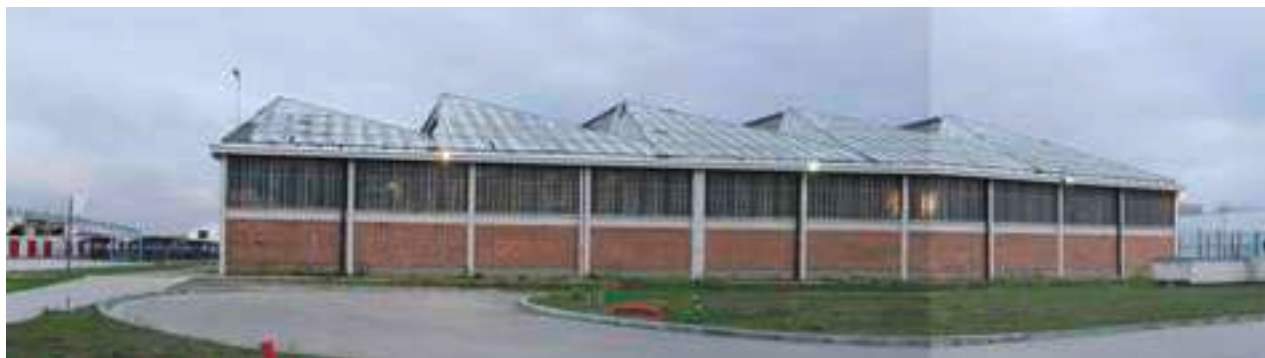
Figuur 78: huidige loodsen, gedeeltelijk behouden
