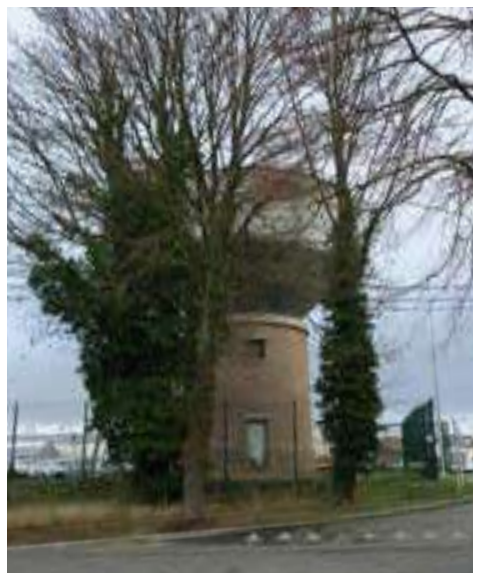
Figuur 79: De watertoren, erfgoed dat een centrale plek krijgt in het plangebied
