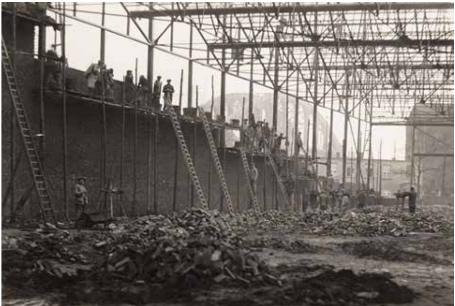
De groentehal in aanbouw met op de achtergrond de spoorwegbrug over de Leuvensesteenweg, vóór mei 1935.
