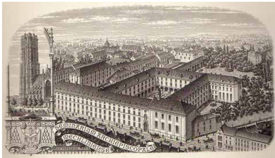
Zicht op het seminariecomplex aan het einde van de 19de eeuw, net voor de bouw van de vleugel uit 1896. De uitbouw in de Frederik de Merodestraat uit 1888 en de nieuwe vleugel in de Varkensstraat zijn duidelijk te zien. © Aartsbisschoppelijk Archief
