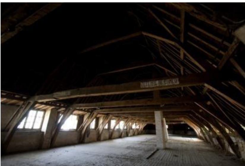
zicht op de dakstructuur van de zolder
