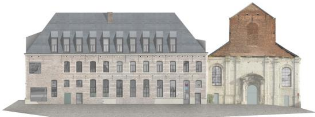
westgevel, fase voorontwerp zomer 2013
