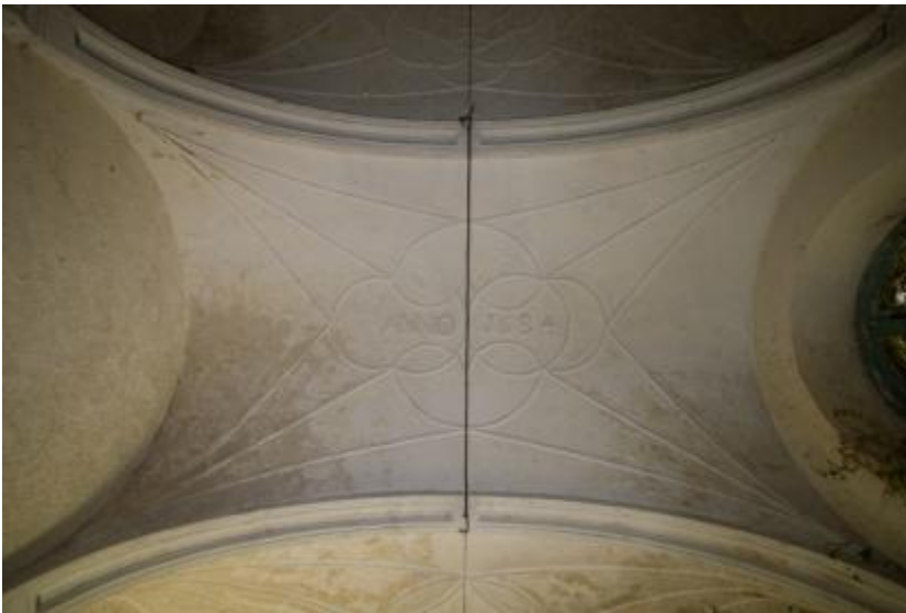
zicht op bepleisterd gewelf met stucwerk
