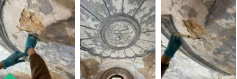
Restaurateurs herstellen de barokke stucplafonds van de middenbeuk. © Callebaut Architecten
