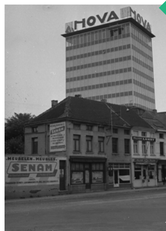
De NOVA-toren gezien vanuit de Nekkerspoelstraat.
