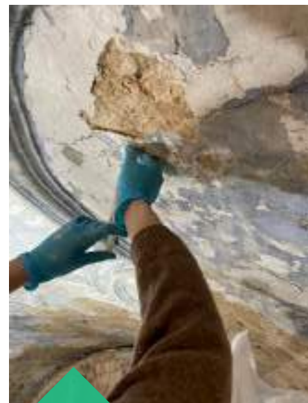
Restaurateurs herstellen de barokke stucplafonds van de middenbeuk. ©Callebaut architecten
