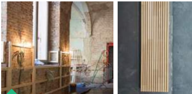
De binnenmuren van het klooster kregen een isolerende houten lambrisering, waarachter ook de leidingen weggewerkt zijn. ©Callebaut architecten
