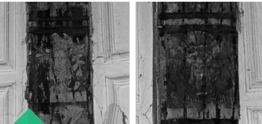
[Bij werken in de jaren 1980 kwamen op enkele balksleutels mascarons in renaissancestijl aan het licht.
