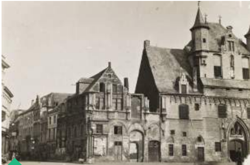
Deze foto van het einde van de 19de eeuw toont de gevarieerde façades van de acht woningen die zich toen in het onafgewerkte Paleis van de Grote Raad bevonden.
