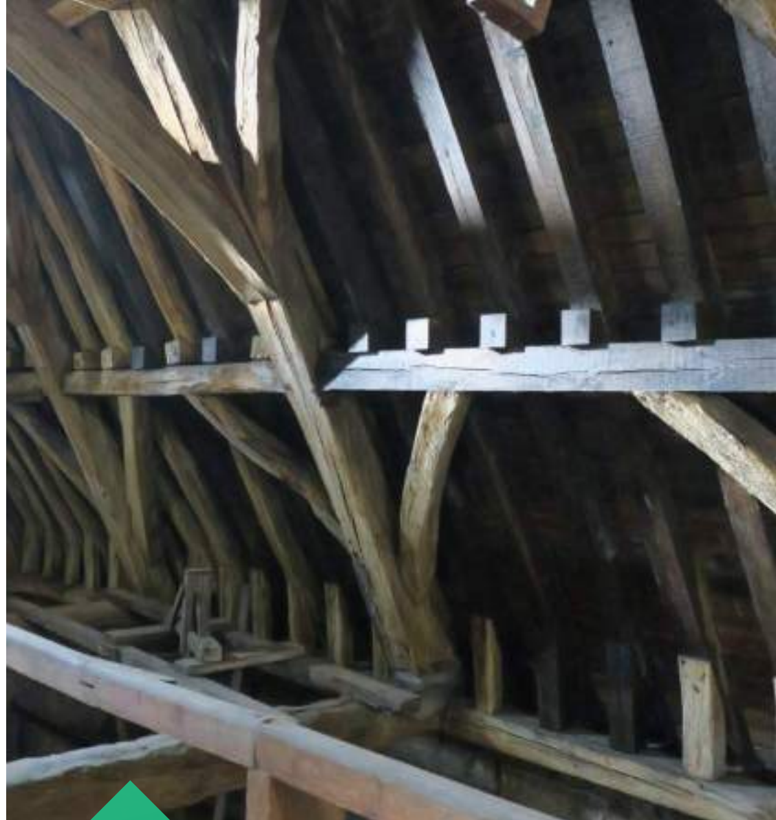
Detail van de rechterzijde van een schaargebint in de dakkap van de Sint-Romboutskathedraal.
