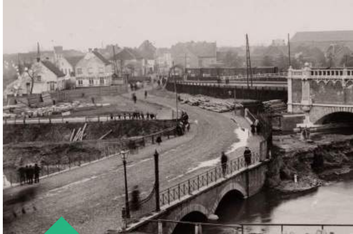
Zicht vanaf het Hoogstratenplein naar de Nekkerspoelstraat rond 1905. Vooraan de kort nadien verwijderde bogenbrug over de in aanleg zijnde Afleringsdijle. Rechts een boog van de spoorwegbrug van circa 1897.
