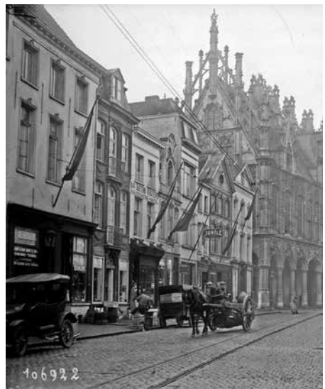
De bepleisterde lijstgevel met versierde vensterlijsten van Bafferstraat 18-20 links op de foto bleef na de splitsing in 1883 aanvankelijk uniform; enkel de opdeling van de winkelpui wijst op de interne verbouwing.
