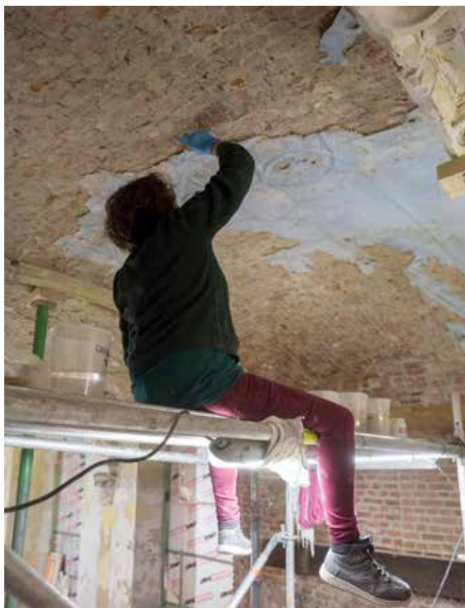
Consolidatie van de bepleistering in de voormalige kloosterbibliotheek. © Callebaut-architecten
