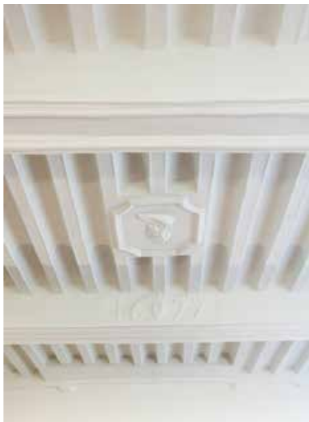
Tijdens de restauratie in 2014-2016 kwamen op de verdieping van het Heilige Geesthuis plafonds met kleigewelven en lijstwerk aan het licht. In het centrale veld bevindt zich een cartouche met Christushoofd en de datering '1677'. © Inge Vermeiren
