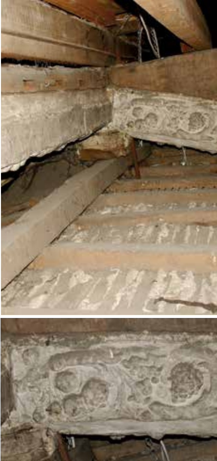
Op de zolder van de Sacramentskapel zijn restanten gevonden van een stucplafond. Op basis van de ornamentiek (engelenhoofdjes, rankwerk en vegetale motieven) en de uitvoeringswijze kan het gesitueerd worden in de eerste helft van de 17de eeuw © Elfi Hermans
