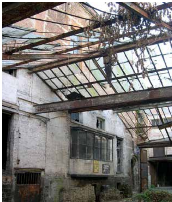
De tuingevel van het Hof van Cortenbach in 2006 met de uitbouw aan de galerij en de glazen overkapping.
