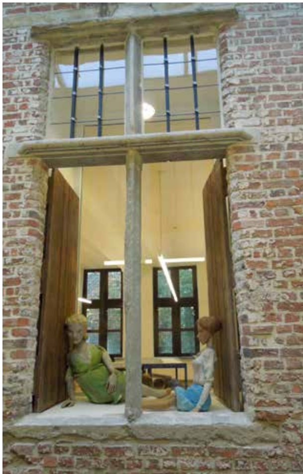
Een 17de-eeuws kruisvenster met authentieke, gerestaureerde buitenluiken in de achtergevel van het Heilige Geesthuis geeft zicht op het atelier van de figuren- en theatermaker. © Sofie Stevens
