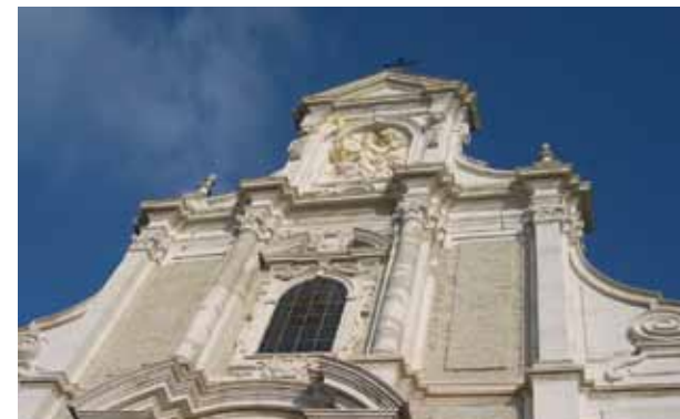
De gedeeltelijk gerestaureerde façade van de begijnhofkerk. © Focus-In, Lint
