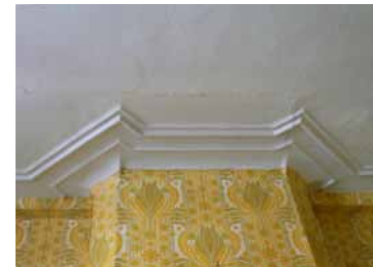
Fijne 18de-eeuwse stuclijsten volgen de omtrek van de schouwboezem met afgeschuinde hoeken in de gelijkvloerse kamer aan de straatzijde. ▼
