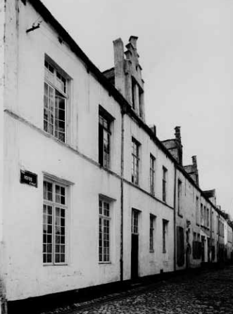
Op deze ongedateerde foto van het KIK zijn de getrapte dakvensters boven de vensteropeningen van de verdieping nog aanwezig.
