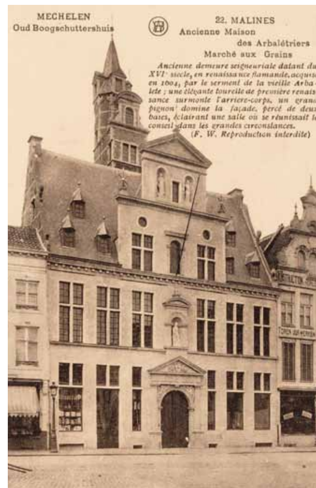
De façade kort na de restauratie van 1912. Een vergelijking met de foto van vóór de werken (pag. 49) toont aan dat er werd afgeweken van de meer conserverend opgevatte restauratieplannen.
