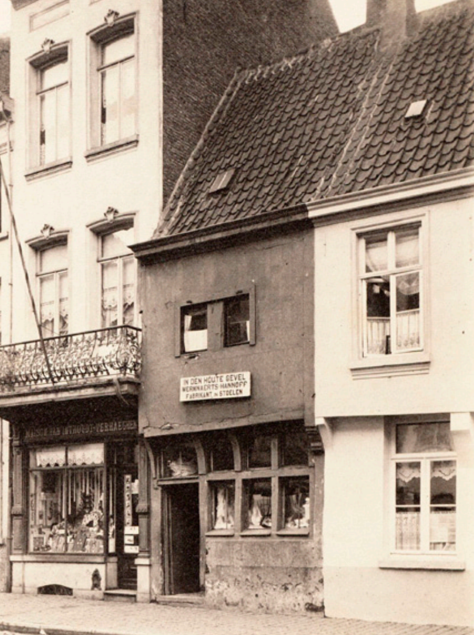
Hanswijkstraat 52 in de eerste helft van de 20ste eeuw. De vergelijkbare houtbouw aan de rechterzijde werd in de jaren 1950 vervangen door een nieuwbouwwoning. Door de bouw van de lijstgevel aan de linkerzijde omstreeks 1850-1875 verdween de linkse scheidingsmuur van Hanswijkstraat 52, net als het linkse zolderjuk.
