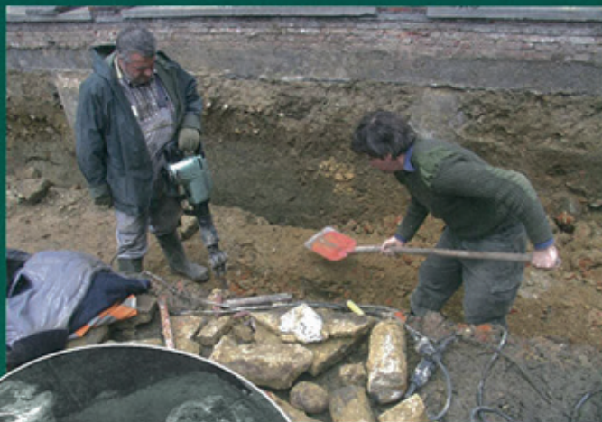
met een zware drillboor worden enkele architectuurfragmenten verwijderd
