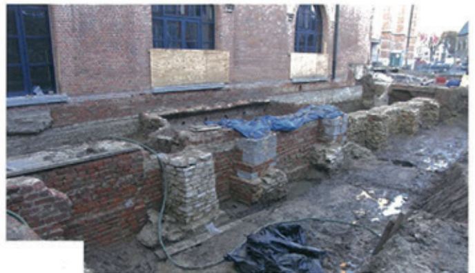
bij de bouw van het klooster in de 14 de eeuw werden naast bakstenen ook gerecupereerde bouwstenen van het oudere klooster gebruikt
