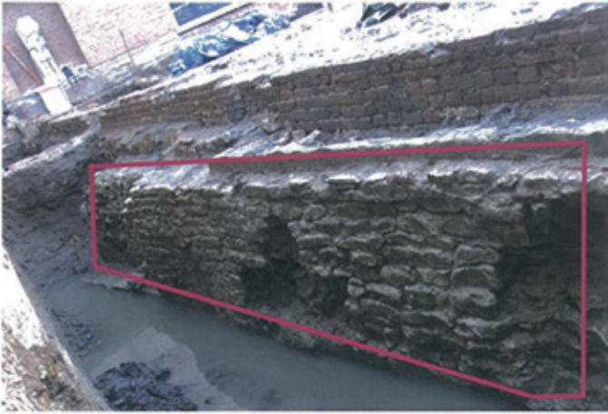
de funderingen waren gebouwd in ruw bewerkte stukken witte kalksteen
