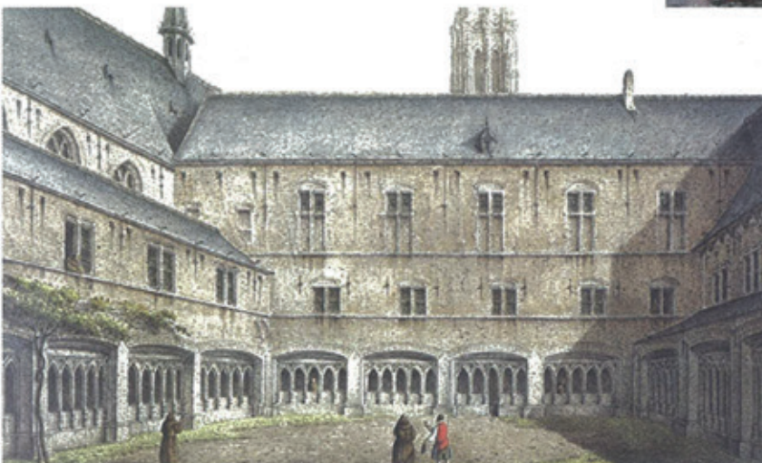
op een tekening van J.B. De Noter zien we de binnentuin en de pandgang
