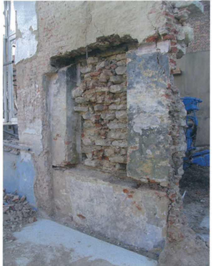
na het afkappen van de muur was te zien waar ooit het raam zat
