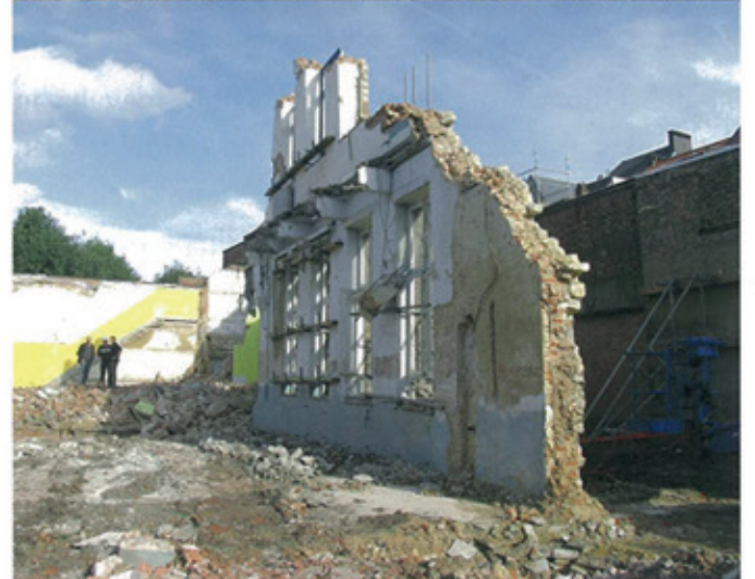
bij de sloop werd een deel van de zuidoostelijke gevel gespaard
