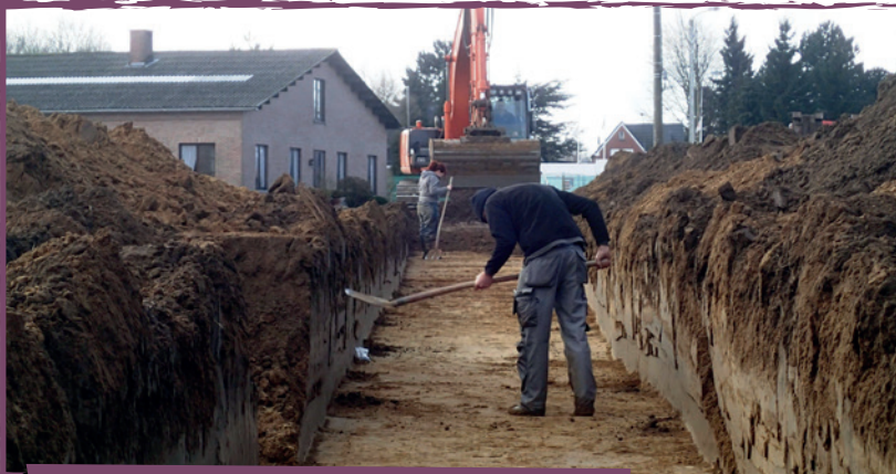
Aanleggen van proefsleuven en kijkvensters (17)
