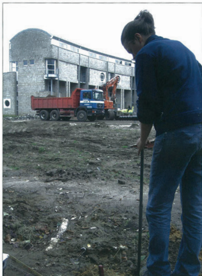
De boring wordt uitgevoerd
