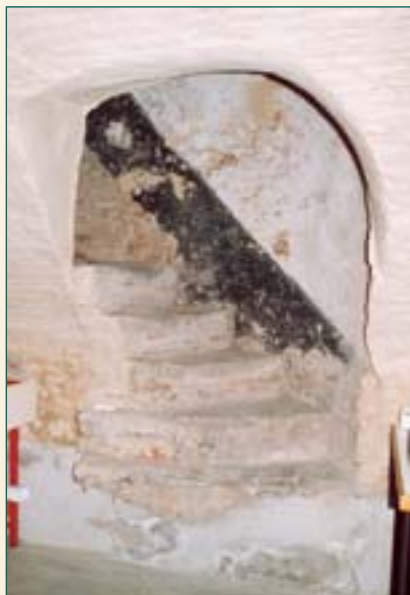
'Oud Schepenhuis', Steenweg: door de bijzondere dikte van de muren kon een trap in de wand uitgespaard worden
