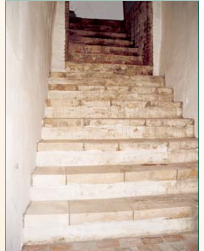
'De Clippel', Korenmarkt: keldertrap die opnieuw werd opengemaakt; zeven treden bevinden zich in de kelder, zeven aan de straatkant
