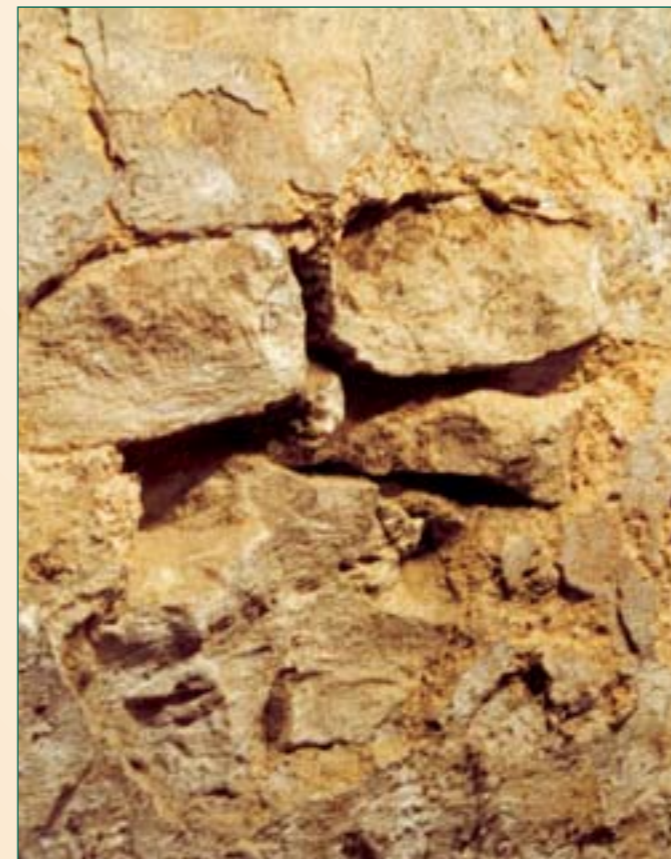
'De Ram', Grote Markt: detail van zeer onregelmatig steenverband (opus incertum)
