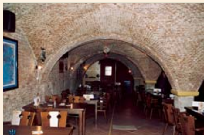
Oude Brusselstraat: 18 de -eeuws ontleisterd 'kruisgewelf' met in het midden één arcadenrij
