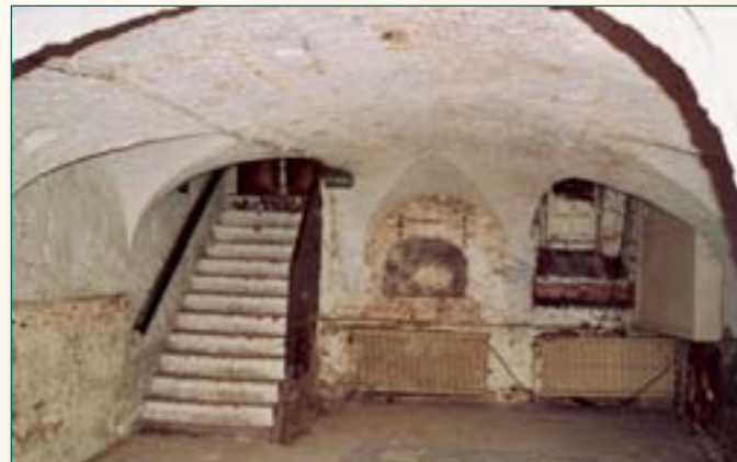
'Hemelrijk', Onze-Lieve-Vrouwestraat: kloostergewelf met gelijkwaardige steekkappen langs de vier zijden van het tongewelf
