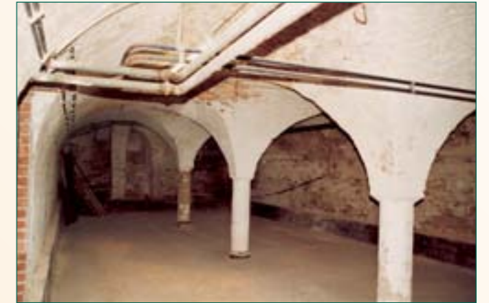
'De Sterre', Grootbrug: twee parallelle segmentbogige tongewelven op een zuilenrij
