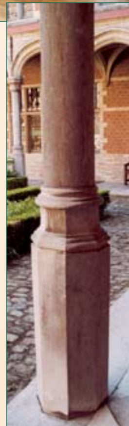
Paleis van Margaretha van Oostenrijk, Keizerstraat: zuilbasis in blauwe hardsteen op binnenplaats.
