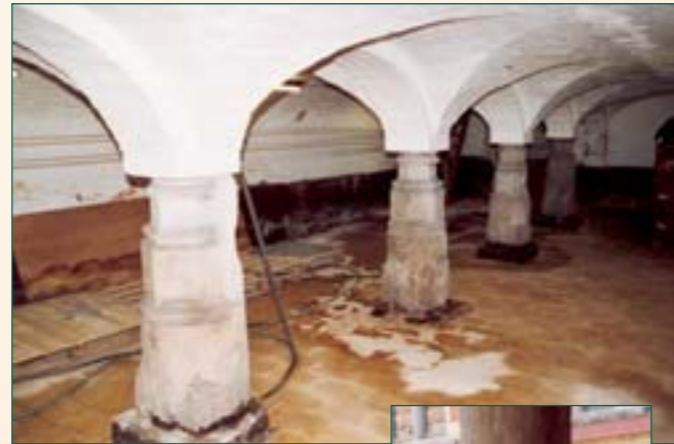
Rik Woutersstraat: vier renaissance-zuilbasissen in blauwe hardsteen in een 19 de -eeuwse kelder
