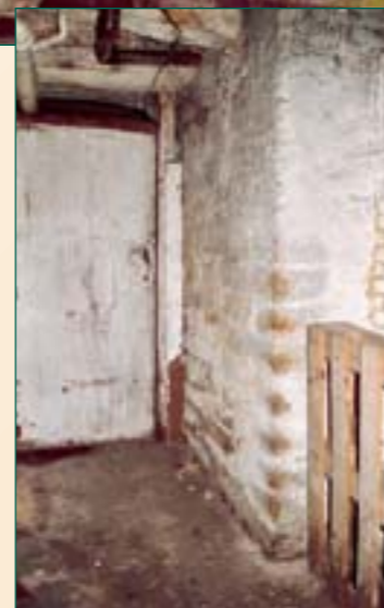
'De Ster', Guldenstraat: binnenzijde achtergevel van 1,48 m dik in regelmatig gehouwen Balegemse steen met fijne voegen
