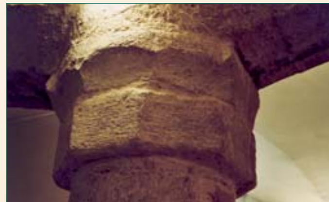
'De Clippel', Korenmarkt: dit kapiteel wijkt af van dat van de andere zuilen in de kelder. Wellicht diende het elders als zuilbasis.
