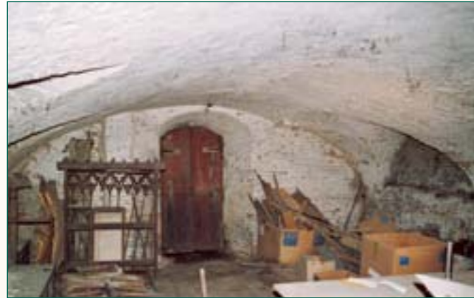
'Refugie van Grimbergen', Onze-Lieve-Vrouwestraat: steekgewelf met ondiepe steekkappen in de twee lange zijden van het tongewelf
