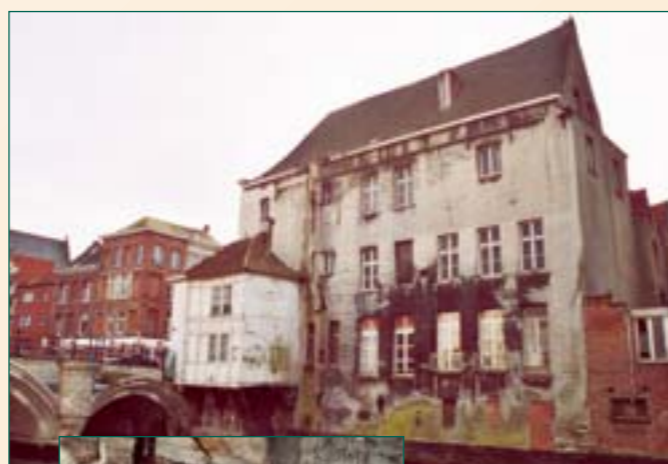
'De Ster', Guldenstraat: binnenzijde achtergevel van 1,48 m dik in regelmatig gehouwen Balegemse steen met fijne voegen
