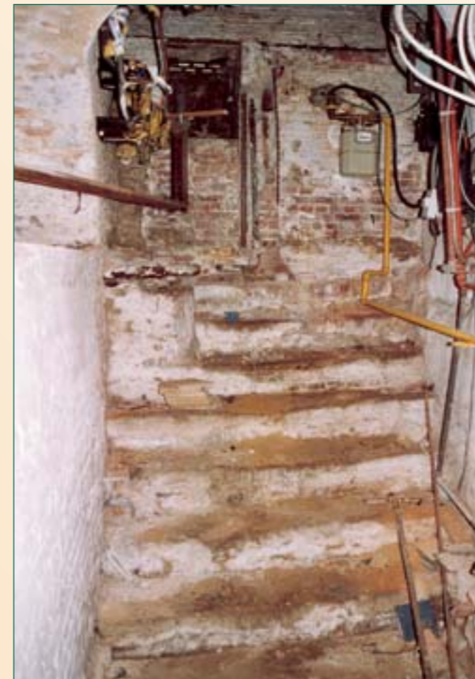
'De Ster', Guldenstraat: keldertrap met zeven treden ter hoogte van de rooilijn dichtgemetseld
