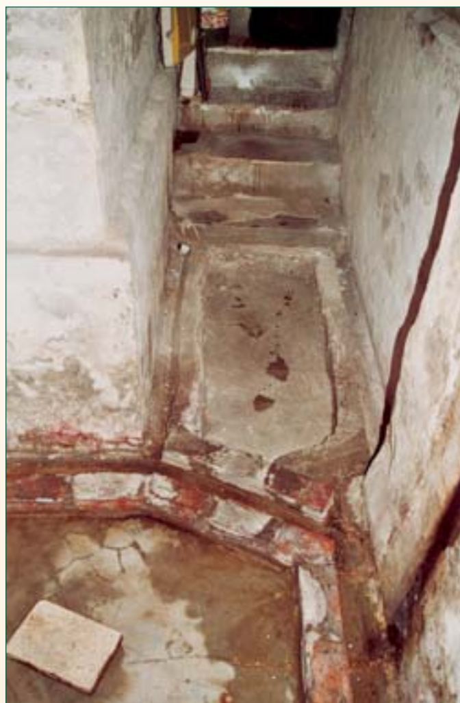
Lange Schipstraat: de watergootjes voeren het water naar één bepaald punt, waar het water overgeheveld wordt in een emmer en vervolgens weggepompt
