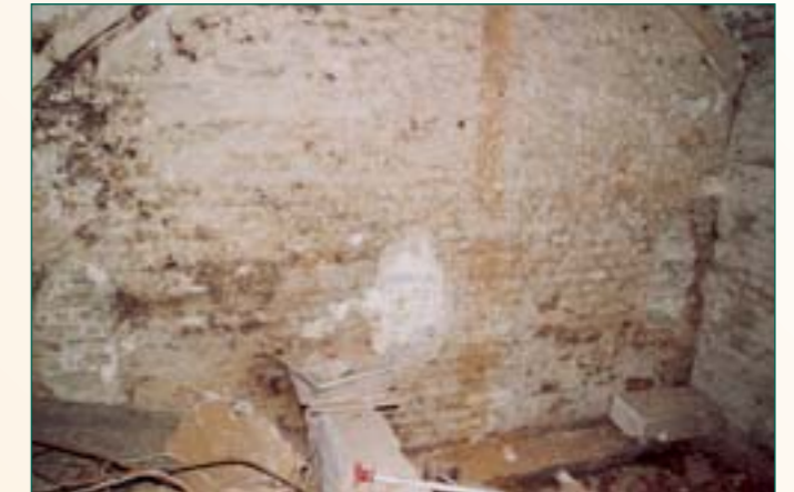
Korenmarkt: de kans is reëel dat deze dichtgemetselde nissen intussen verdwenen zijn achter een voorzetwand van snelbouwstenen!
