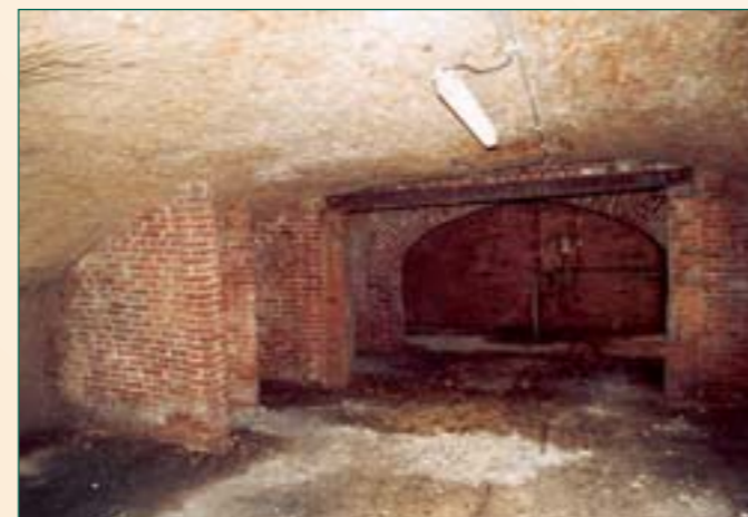
'De Roden Hoet', Grote Markt: het tongewelf van deze kelder en straatkelder overspant een grotere ruimte dan gemiddeld: 6.30m breed. De zijmuurtjes ondersteunen tegelijkertijd het gewelf en vormen ruimtes voor de opslag van handelswaar
