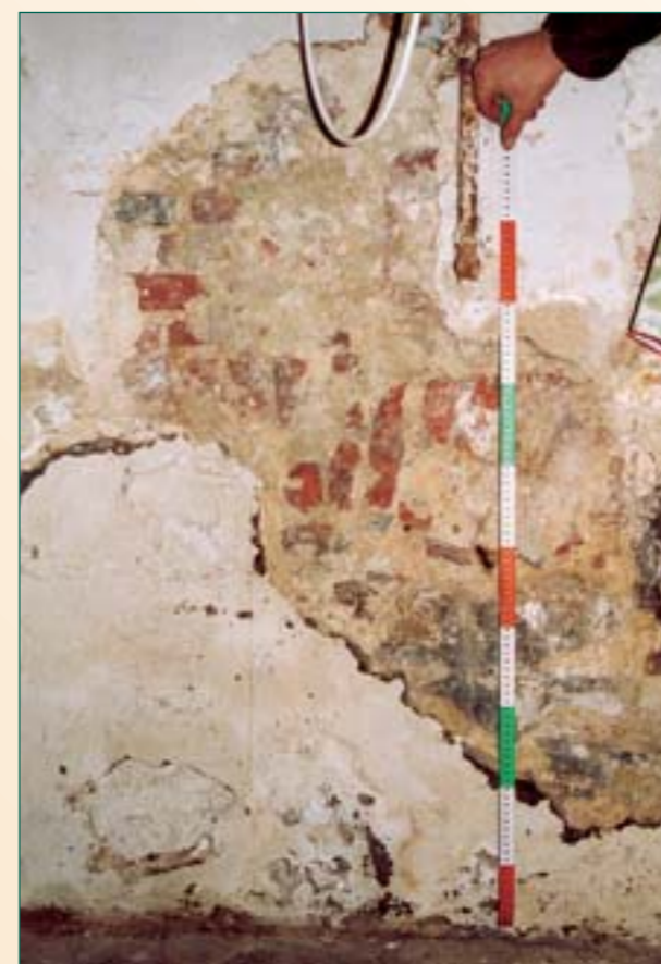
Guldenstraat: vaak zat het bouw materiaal achter een dikke pleisterlaag en niet iedereen stelt het op prijs zijn kelder te laten strippen....
