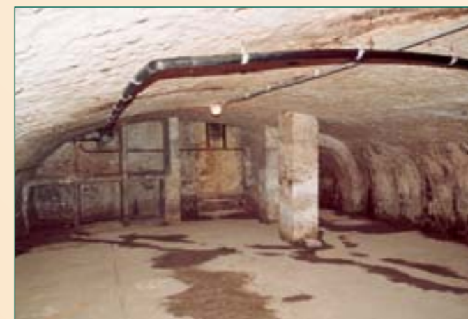
Lange Schipstraat: korbboogig gewelf van 5.60m breedte op de straat met zeer dikke zijmuur (1.50m!)
