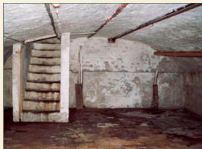
Van Benedenlaan: kelder met 19 de -eeuws tongewelf en steektrap langs de erfzijde
