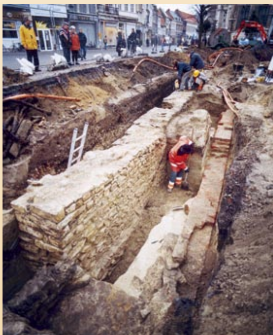
lange bakstenen 13 de -eeuwse muur parallel aan en vlakbij de 12 de -eeuwse muur.
