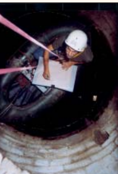
Vanuit een bootje werd het metselwerk aan de binnenzijde van de waterput ingetekend.
