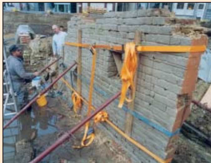
Het voorbereiden van de muur vooraleer hij verhuisd wordt.
