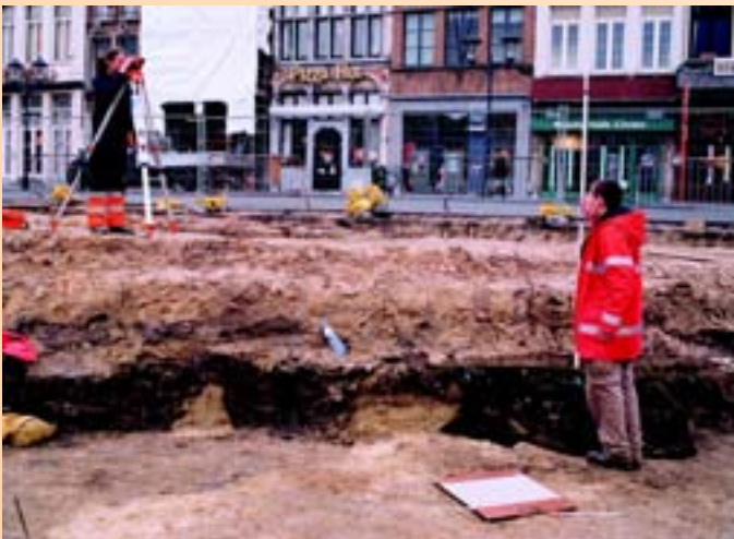
hoogtemetingen gebeuren met de niveauijker
