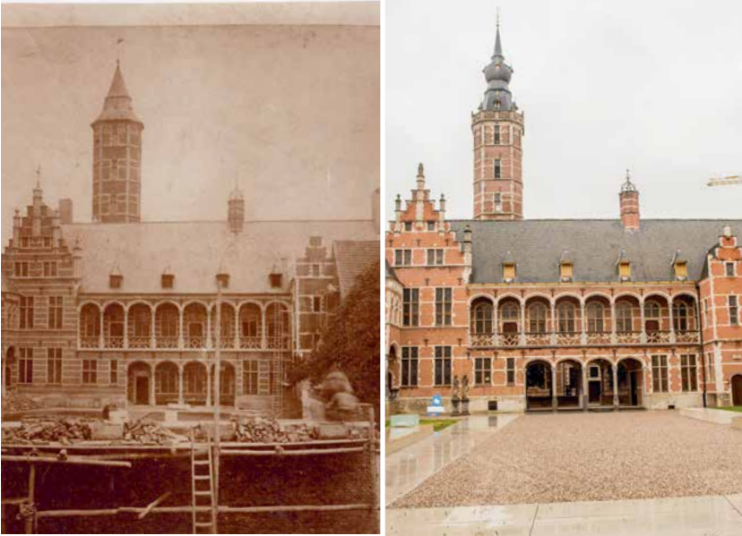
■ Het Hof van Busleyden in 1864 (tijdens renovatiewerken) en nu
