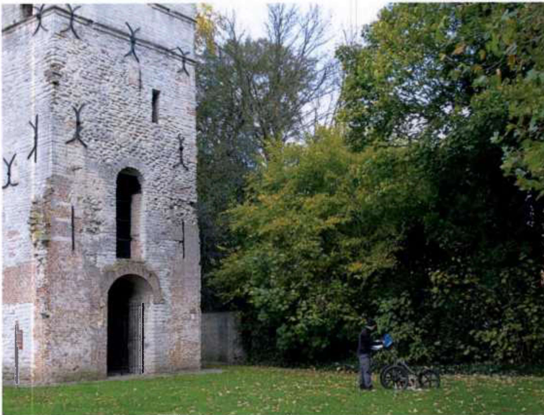
Figuur 9: geofysisch onderzoek met grondradar ter hoogte van de locatie van de centraalbouw.
