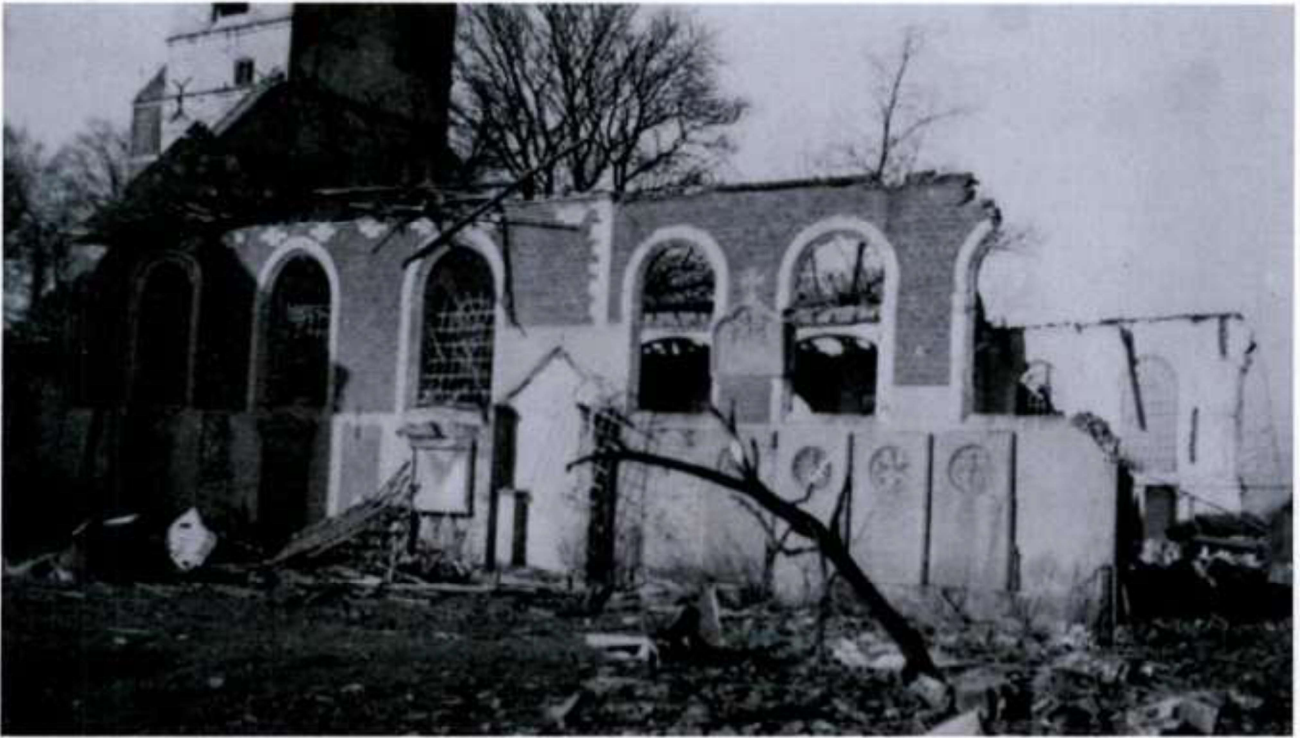
Figuur 3: De kerk na de V1-inslag in november 1944. Enkel de toren bleef overeind (foto W. Schaltin).
