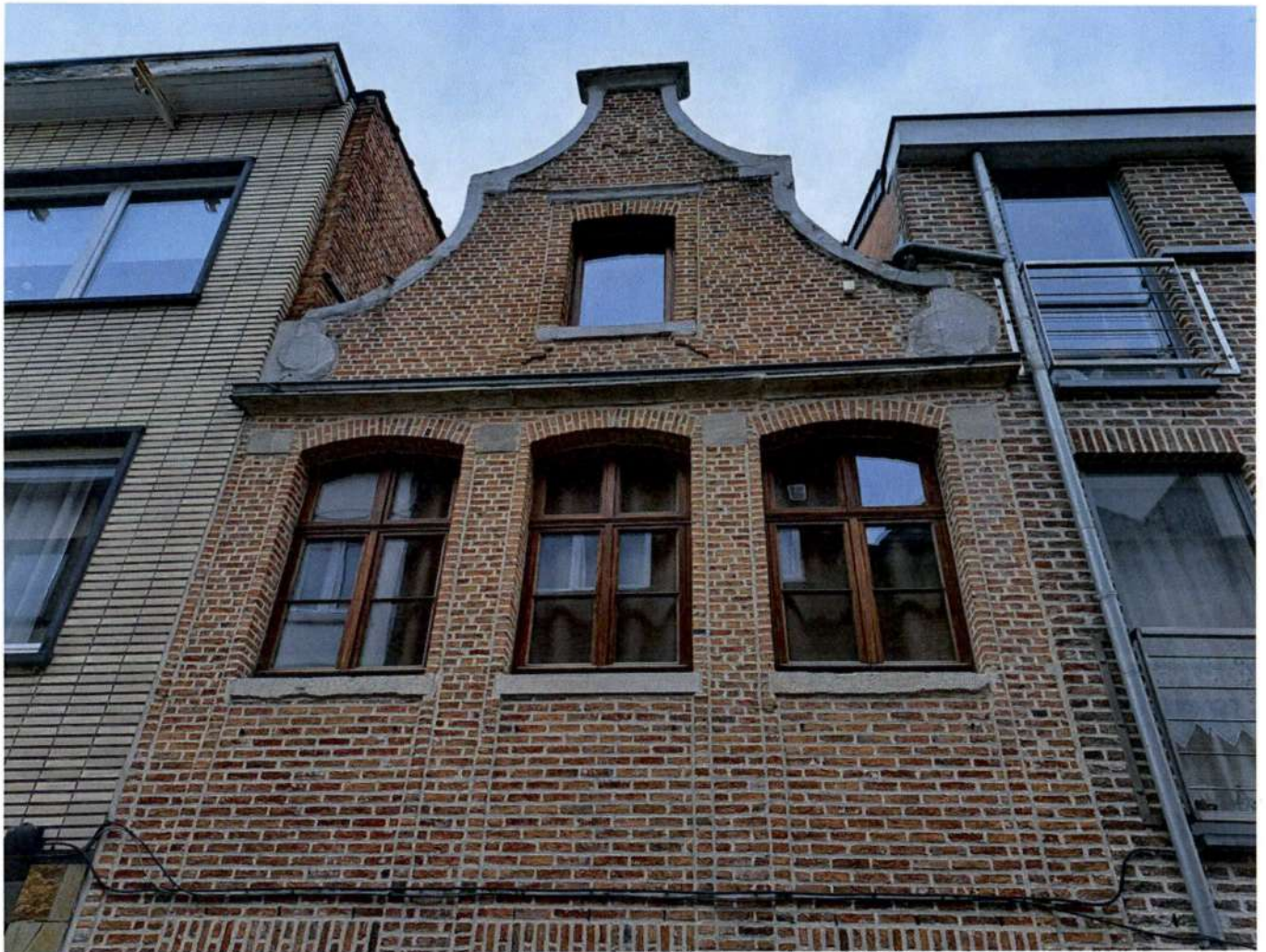
Foto 6: Detail bovengevel (15 december 2023)
