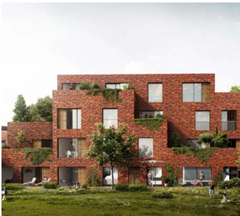
Appartementen (Teglvaerkskvarteret, Esbjerg, DK)
