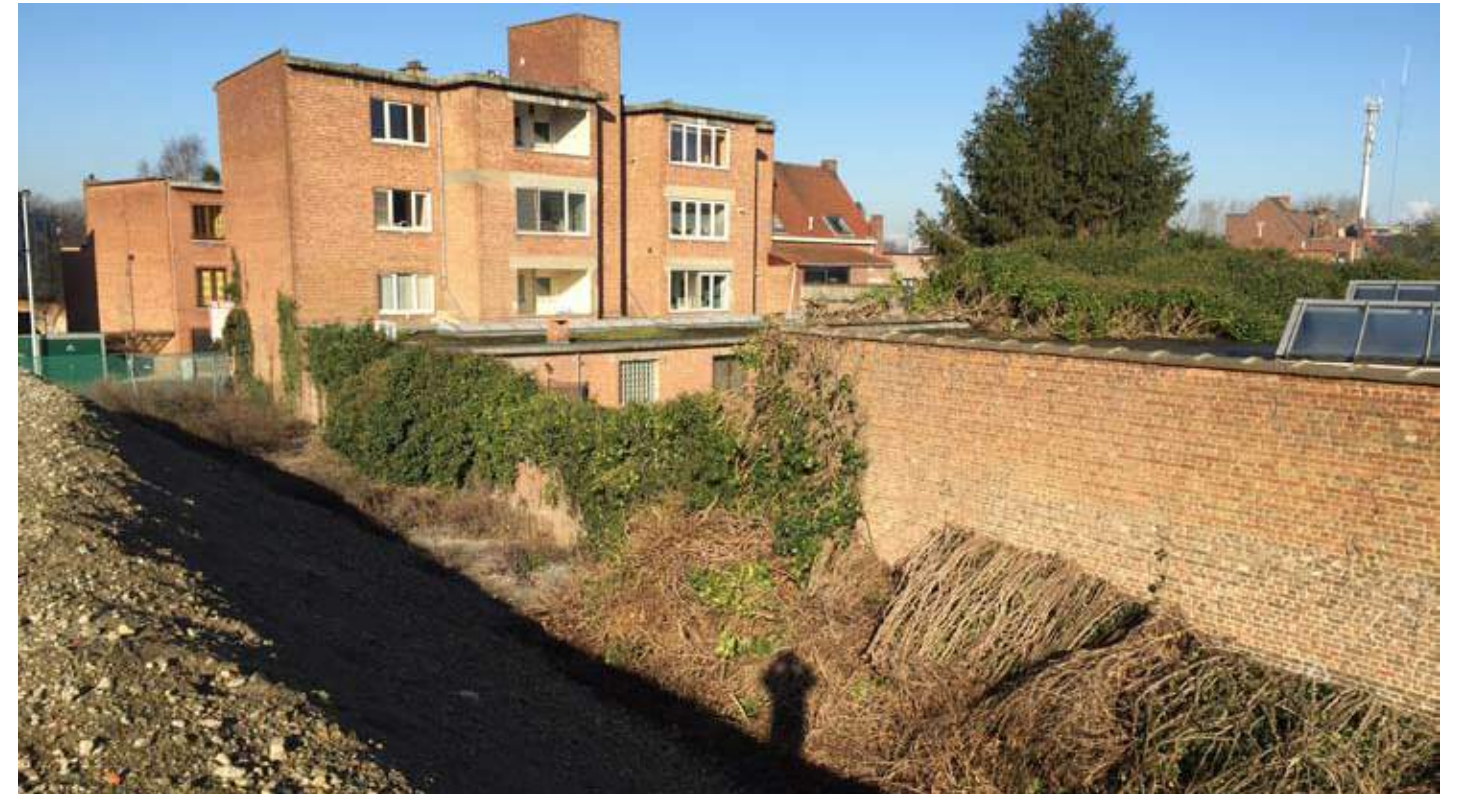
12. APPARTEMENTSGEBOUW NAAST WONINGEN
