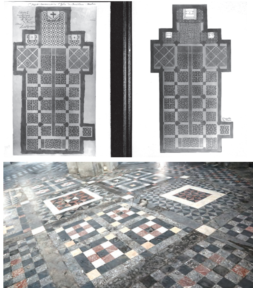
Figuur 6: Twee ontwerpen voor de vloer. www.regionalebeeldbank.be Figuur 7: Zicht op de natuurstenenvloer ter hoogte van het transept, MJ 2023
