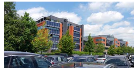
Figuur 301: bestaande gebouwen De Lijn en Crescent en bovengrondse parking
