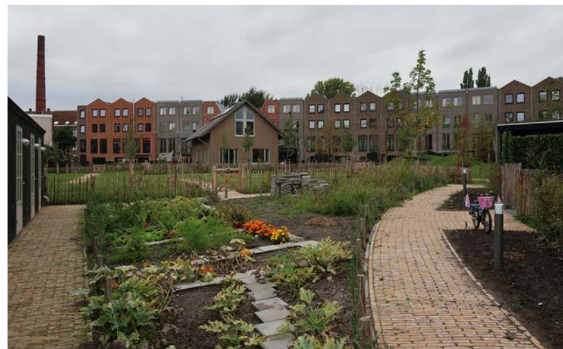
Figuur 228: Referentie binnenkant, Nieuw Crooswijk Rotterdam
