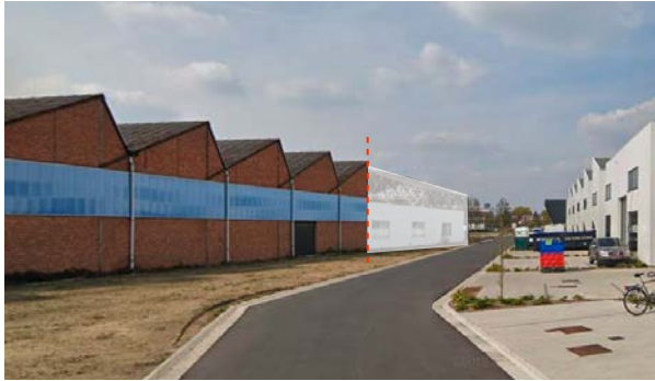
Figuur 317: Beeld bestaande Brextonloods met aanduiding te vervangen kop
