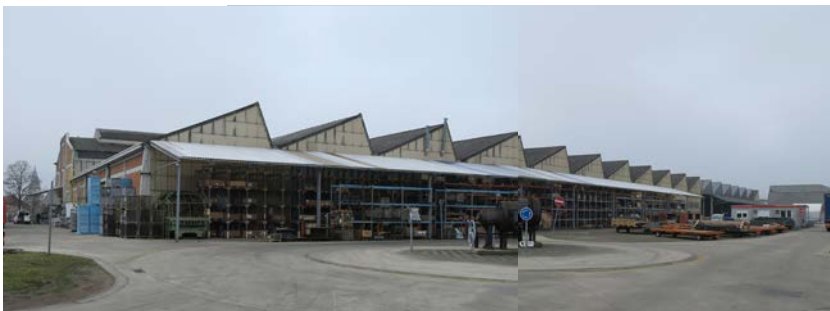
Figuur 280: Foto's bestaande toestand loodsen
