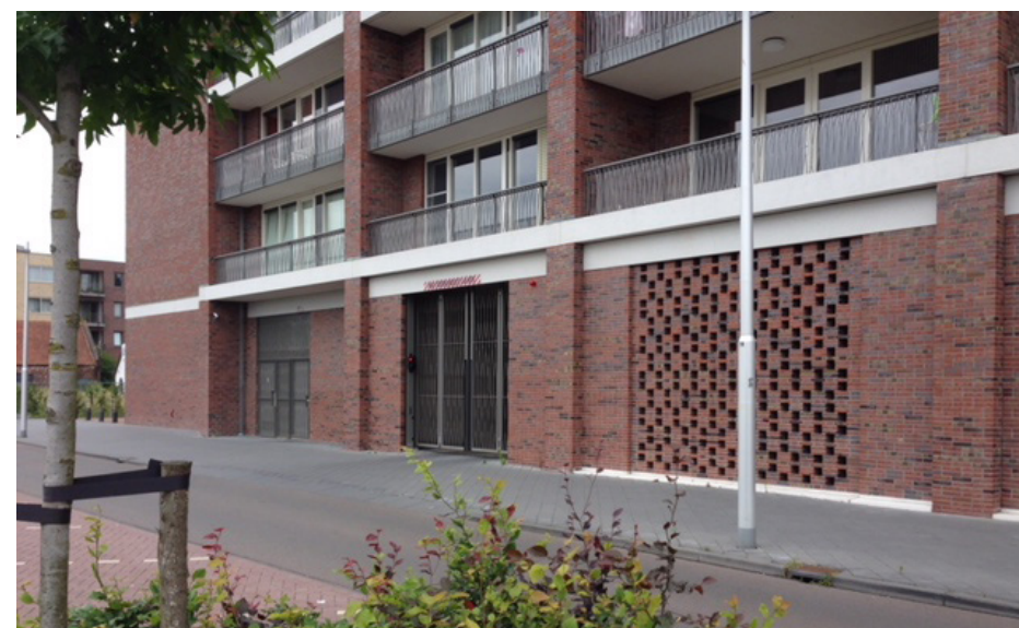
Figuur 244: Referentie volwaardige afwerking van logistieke toegangen, onderdoorgangen, parkeertoegangen
