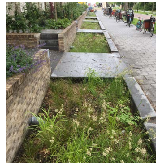
Figuur 162: Detail boordsteen met instroom van opgevangen regenwater, schaal 1:50
