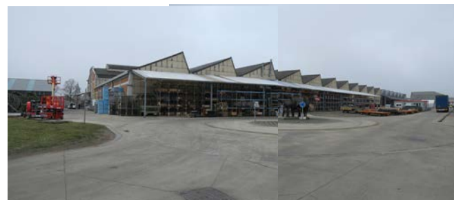
Figuur 30: Loodsen van de Centrale Werkplaats
