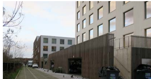
Figuur 26: Het gebouw van Fred & Ginger
