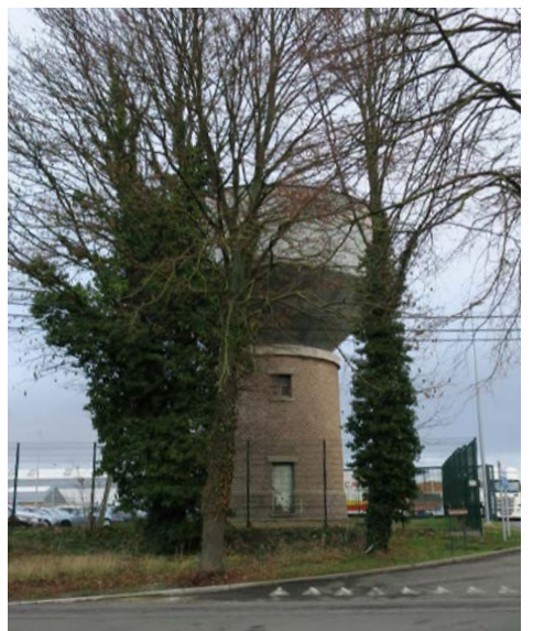
Figuur 79: De watertoren, erfgoed dat een centrale plek krijgt in het plangebied
