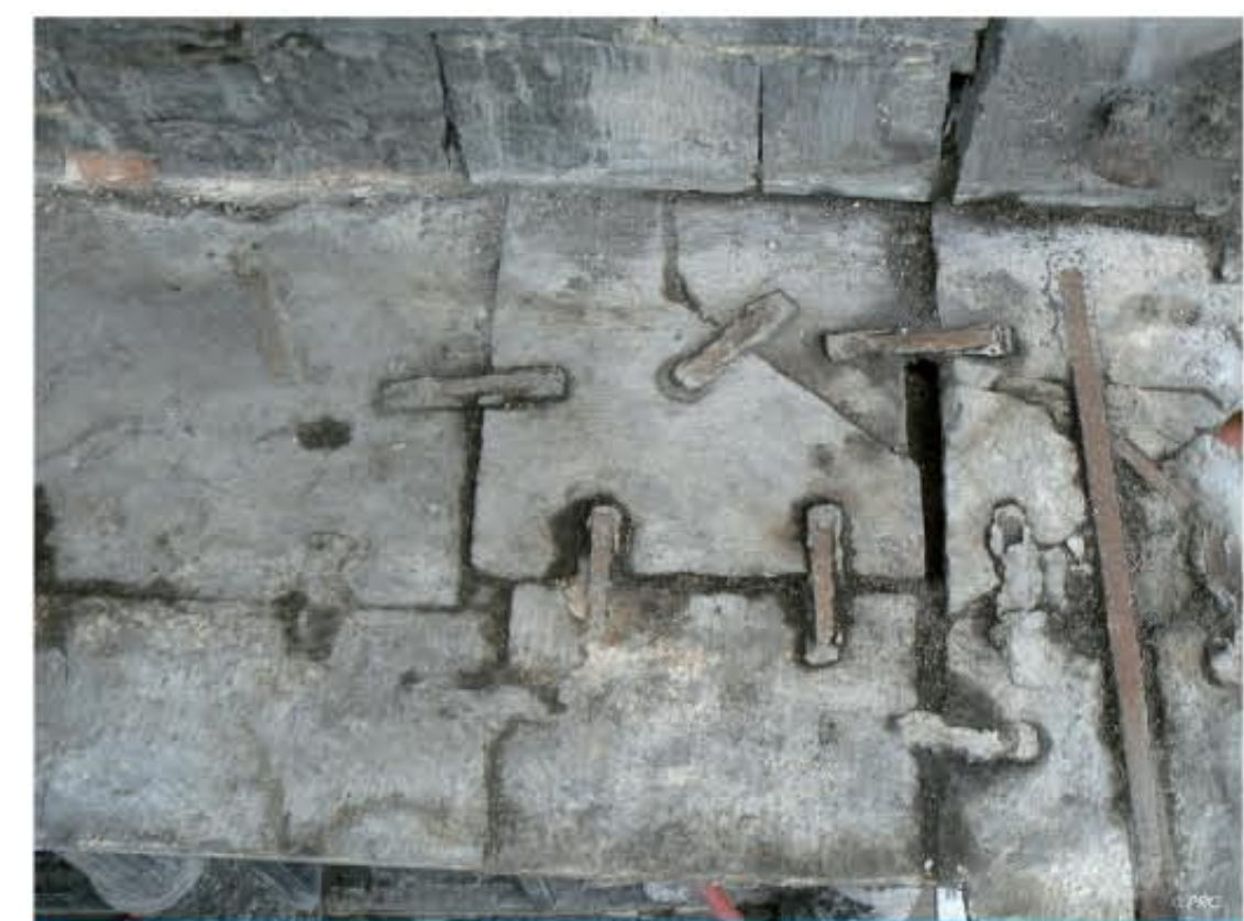
▲ Aan het bovenste deel van de 16de-eeuwse gevel sijpelde water in. De kooflijst wordt nu beschermd tegen de regen door een loden afwerking.
