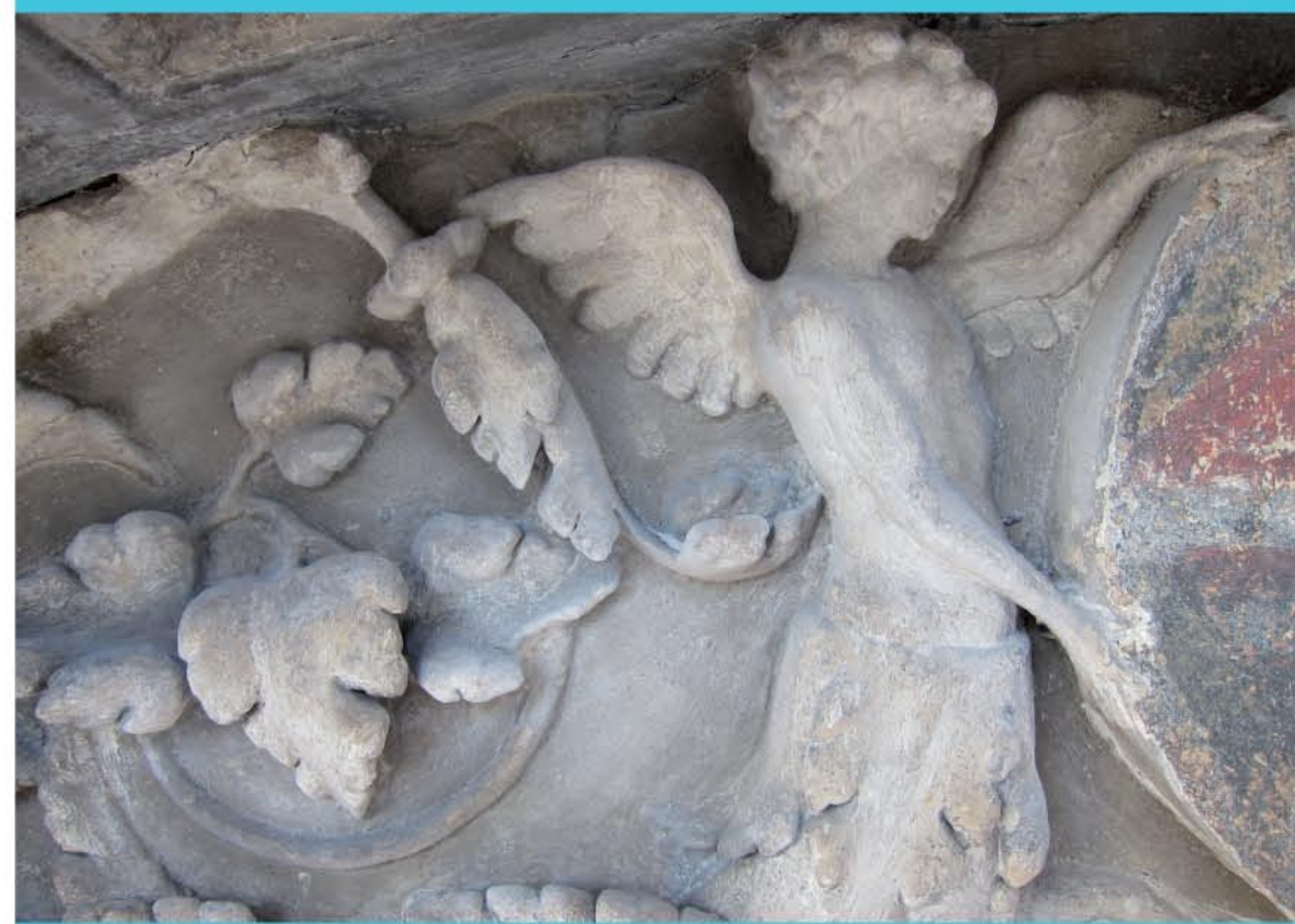
▲ De proefrestauratie omvatte de consolidatie van de natuursteen en de aanvullingen in gips, het opvullen van barsten, lacunes en holtes, het fixeren van de verflagen, het zacht reinigen en vrijleggen van de tweekleurige afwerking van de 19de eeuw. Uiteindelijk worden er plaatselijk retouches aangebracht.
