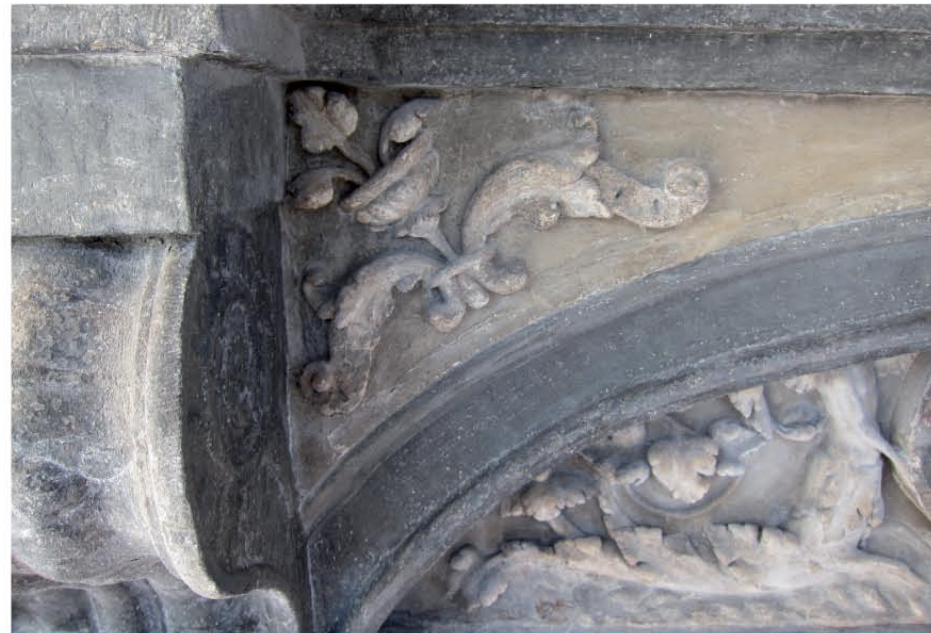
▲ De proefrestauratie omvatte de consolidatie van de natuursteen en de aanvullingen in gips, het opvullen van barsten, lacunes en holtes, het fixeren van de verflagen, het zacht reinigen en vrijleggen van de tweekleurige afwerking van de 19de eeuw. Uiteindelijk worden er plaatselijk retouches aangebracht.
