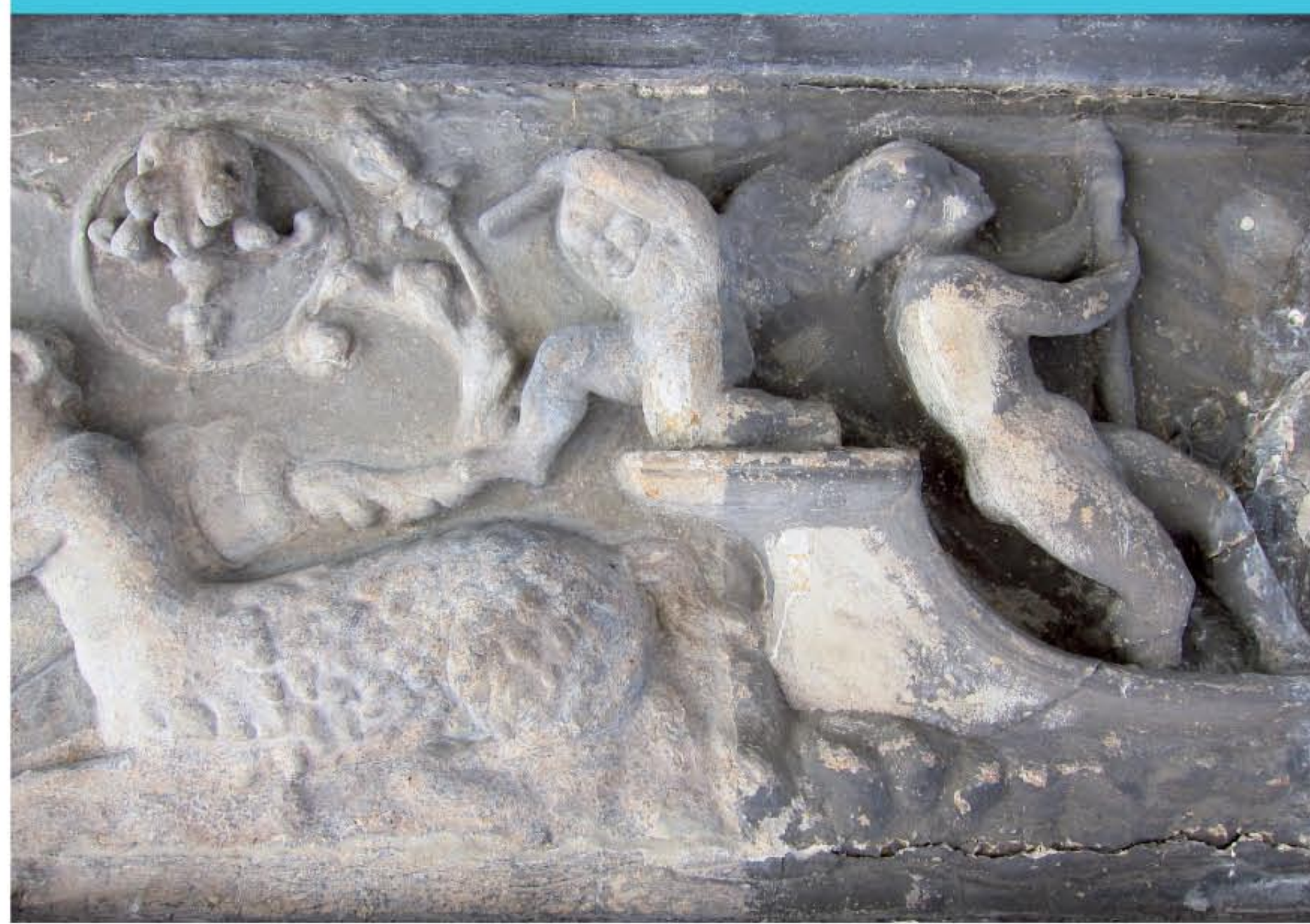
▲ De proefrestauratie op het rechte boogveld boven het gelijkvloers geeft aan de linkerzijde weer hoe de gevel van 'In Den Grooten Zalm' er zal uitzien na de huidige restauratiewerken. Aan de rechterzijde werden al de hoogst dringende consolidatiewerken gedaan om de 19de-eeuwse aanvullingen met gips niet volledig te verliezen.
