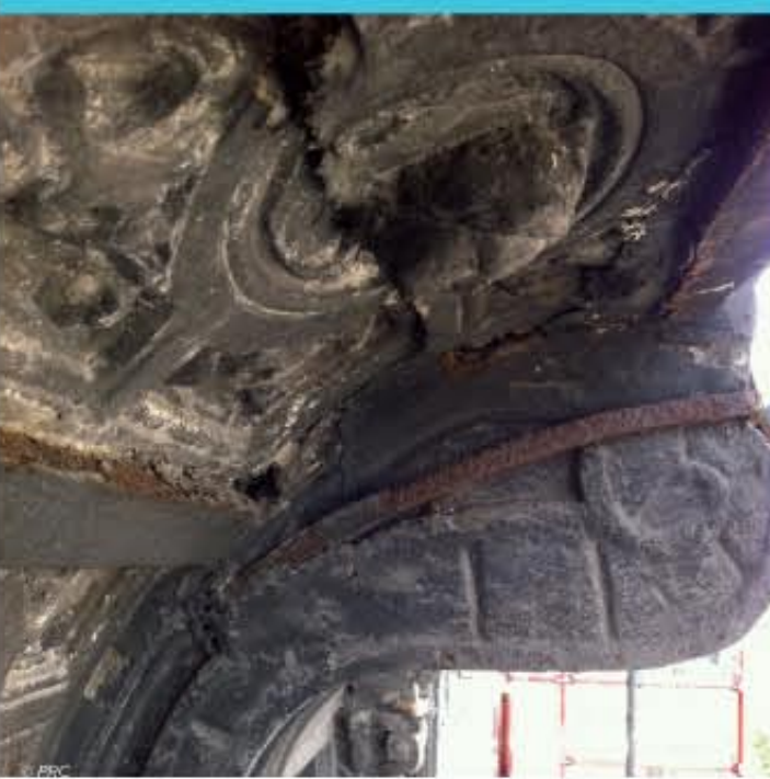
▲ Aan het bovenste deel van de 16de-eeuwse gevel sijpelde water in. De kooflijst wordt nu beschermd tegen de regen door een loden afwerking.
