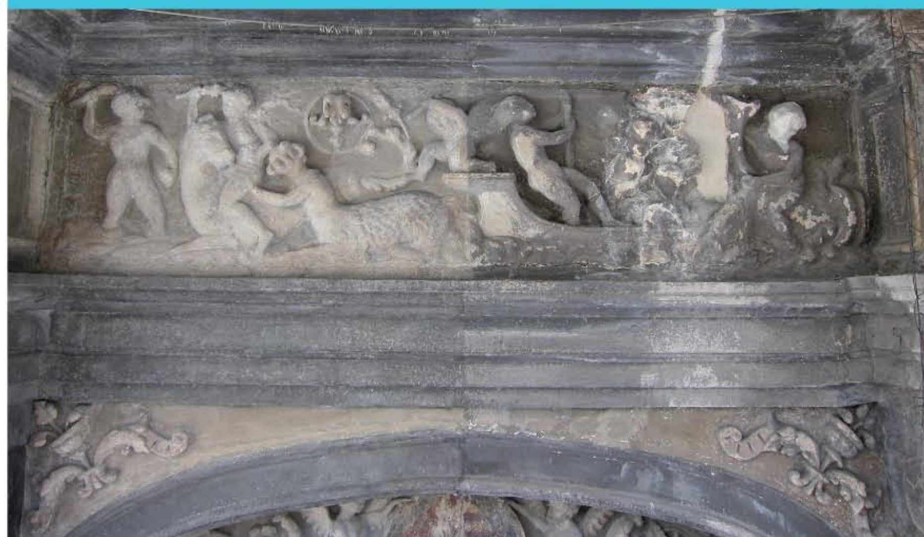
▲ De proefrestauratie op het rechte boogveld boven het gelijkvloers geeft aan de linkerzijde weer hoe de gevel van 'In Den Grooten Zalm' er zal uitzien na de huidige restauratiewerken. Aan de rechterzijde werden al de hoogst dringende consolidatiewerken gedaan om de 19de-eeuwse aanvullingen met gips niet volledig te verliezen.
