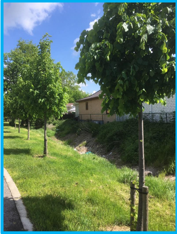
Stabiliteitsproblematiek t.h.v. gracht zijde Kolveniersgilde
