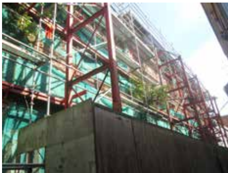
Noodzakelijke schoringswerken in 2014.
