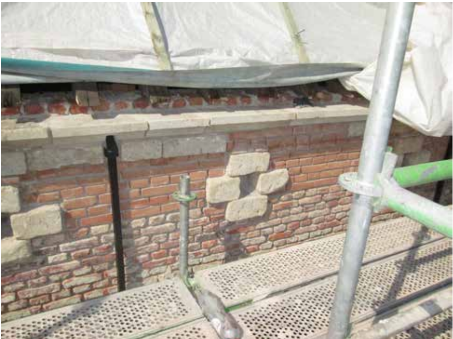
Restauratie van de gevels van bak- en zandsteen. © Callebaut- architecten
