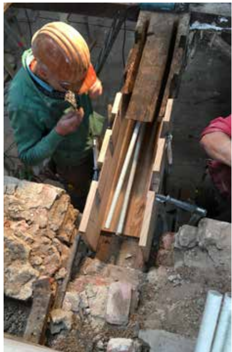
Polymeerchemisch herstel van de balkkoppen.
