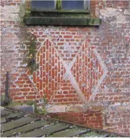
Detail van het ruitvormige metselpatroon boven de vensteropeningen van de benedenverdieping.
