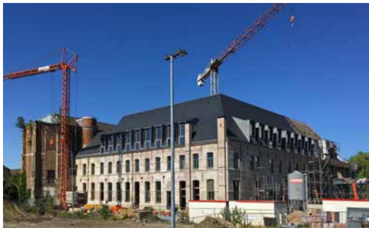
De afgewerkte oostgevel in 2017 © Callebaut- architecten
