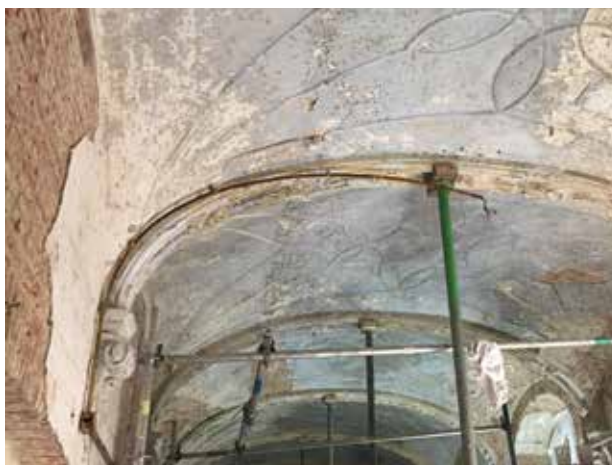
Consolidatie van de bepleistering in de voormalige kloosterbibliotheek
