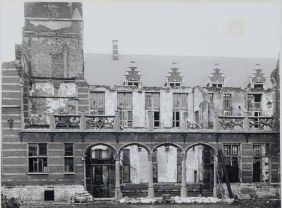
Het Hof van Busleyden kort na het begin van de Eerste Wereldoorlog. Onder meer de verdieping van de tuin vleugel ging in vlammen op, waardoor de muurschilderingen in het gelijkvloerse hypocaustum - links op de foto - aan weer en wind waren blootgesteld.
