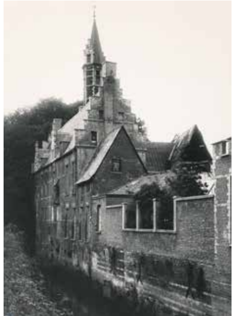
De halfondergrondse kelder naast de keuken gaf via een korfboogvormige deuropening uit op de vliet de Melaan. Etenswaren, brandhout en ander gerei konden zo op een efficiënte manier per boot aangevoerd worden.
