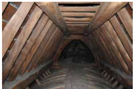
Het dakgebinte van de middenbeuk, zicht naar het westen. © VandenBorre-Lauwers bvba
