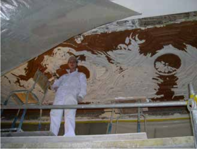
Als laatste fase van de restauratie werden de stucplafonds in de pandgang in hun laatbarokke glorie hersteld.
