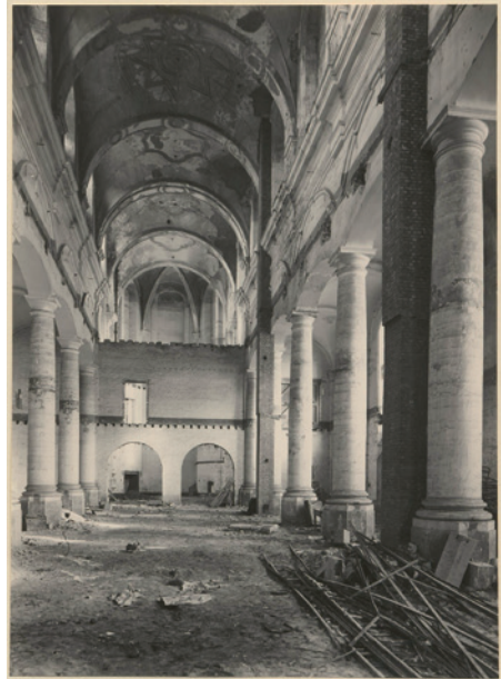
De 19de-eeuwse tussenniveaus in de midden- en zijbeuken van de kerk verdwenen na een brand in 1946. De tussenmuurtjes met sporen van draagbalken op deze foto geven aan op welke hoogte de tussenniveaus zich bevonden.
