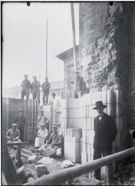
Deze foto uit 1930 toont hoe de plint en het glasraam van de vroeggotische kapel werden weggebroken om er Merciers grafkapel te kunnen inpassen. De man met de hoed uiterst rechts is vermoedelijk architect Simon Van Craen.
