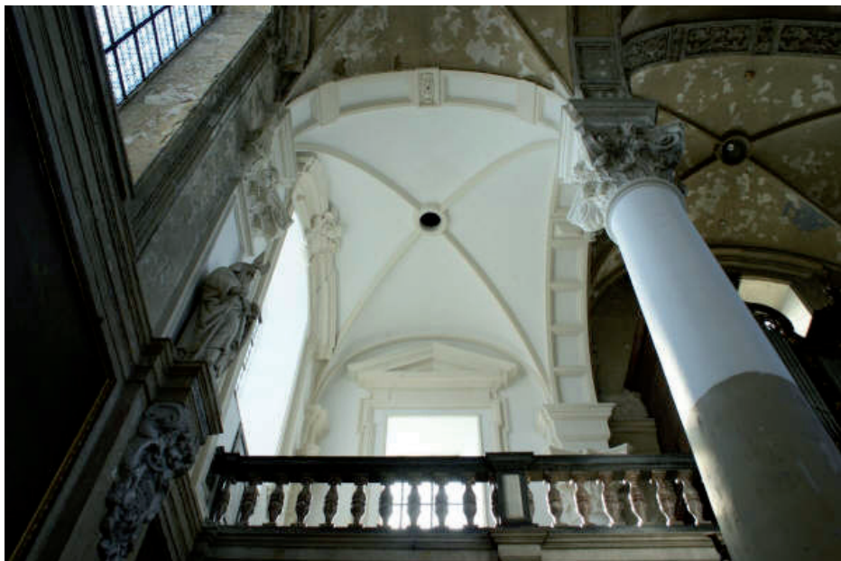
De westelijke travee van de zuidelijke zijbeuk na de bichrome proefrestauratie. ©studiebureau Examino.
