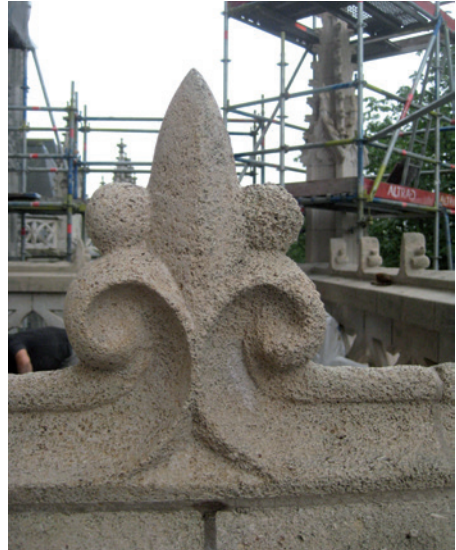
Deze foto toont een ornament waarvan enkel de linkerhelft werd opgeschuurd.
