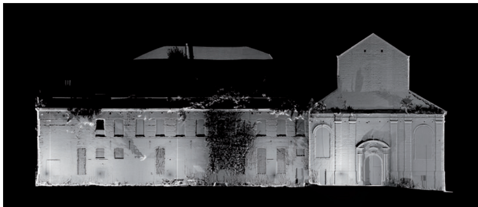
Deze orthofoto toont de gelaagdheid van de eerdere verbouwingen van de westgevel van de kerk en van het klooster. ©Klepsch Ingenieurgesellschaft mbh
