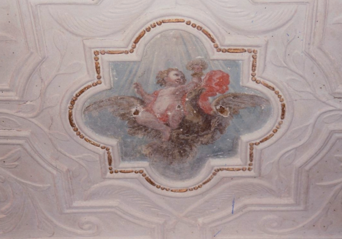
Het 17de-eeuwse stucplafond met een centrale schildering in de opkamer tijdens de restauratie.
