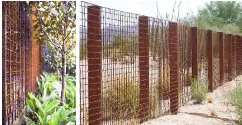
Afsluiting in betonnetten
