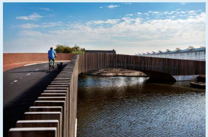
referentie - vleermuizen brug; gebruik van verschillende materialen (Vlotwateringbrug Westlandn NL) - Ontwerp: NEXT architecten
