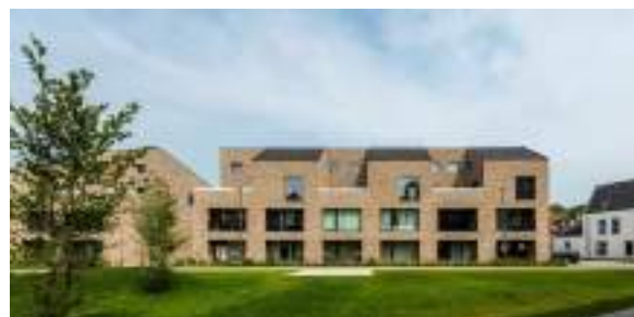
De Indruk, Brugge, Cameleon architects
