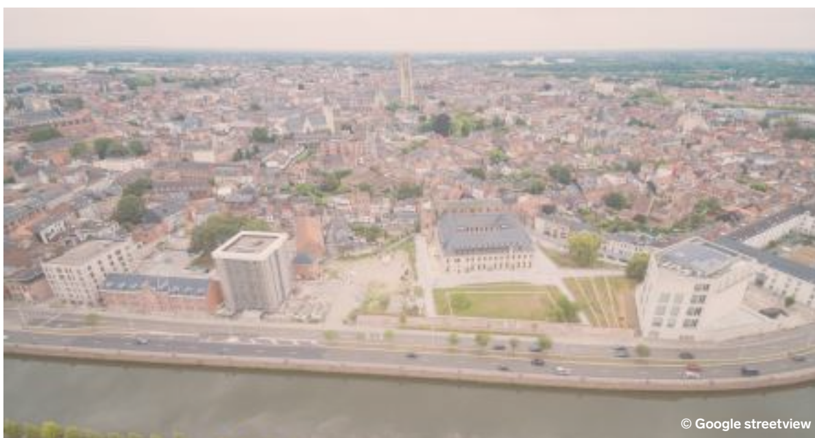
Recent gerealiseerd project op de Tinel-site
