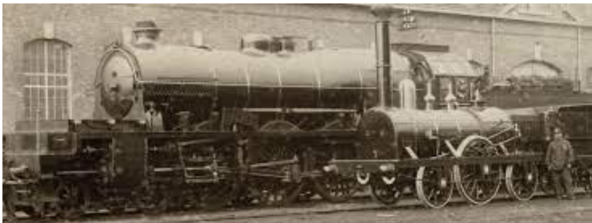
Centrale werkplaats Arsenaal (© beeldenbank Mechelen)
