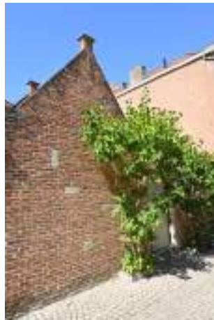
AZA 3 Type B (tuinmuur, bijgebouw en voorgevel TAP)
