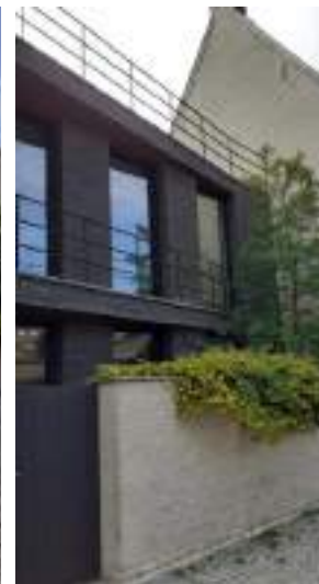
BEG 4 Type E (voorzijde), G (achtergevel) en C2 (tuinmuur achtergevel)
