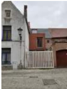
NBE 28 Type C2 (achtergevel) en G (moderne aanbouw)
