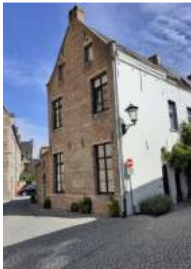
MOR 6 Type D (voorgevel), C2 (tuinmuur) en A1 (achtergevel)
