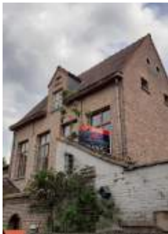
NON 4 Type C2 (gevels en tuinmuur)
