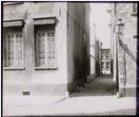
Zicht vanuit de Nonnenstraat op de Krankenstraat, SME002000266, glasplaat, ca 1900?
