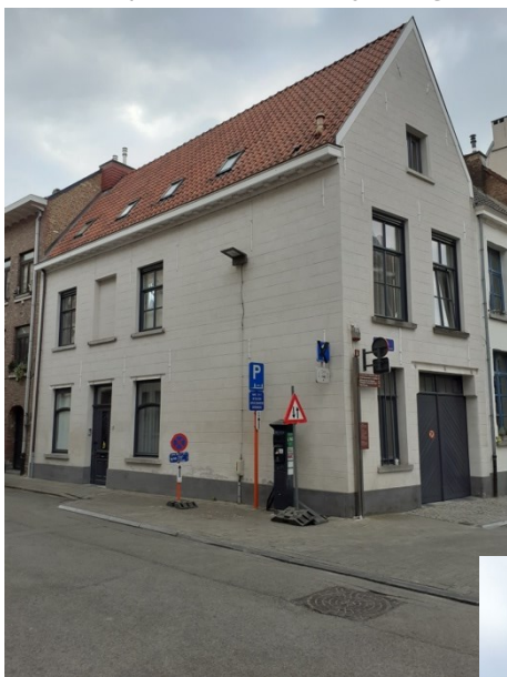
Cementpleister met schijnvoegen
