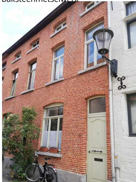
Lijstgevel met rood baksteenmetselwerk
