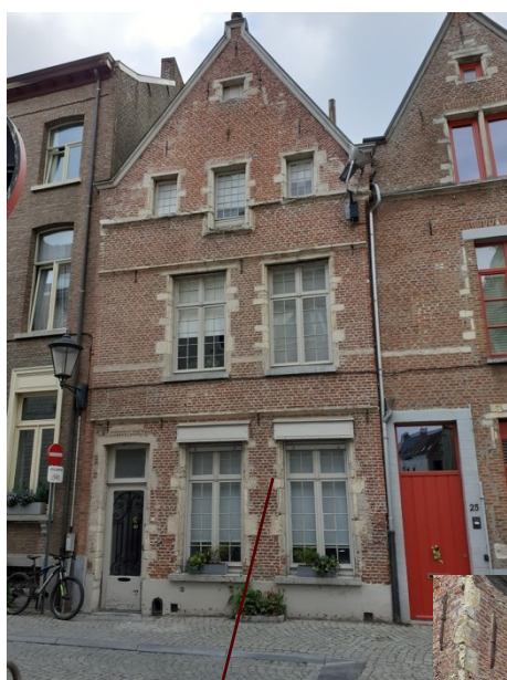
Kwarthol geprofileerde raamomlijsting met negblokken
