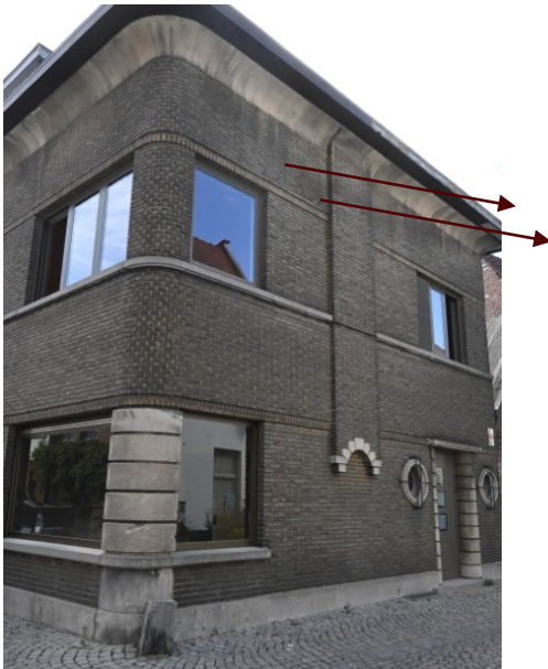
Gevel in decoratief geel metselwerk
