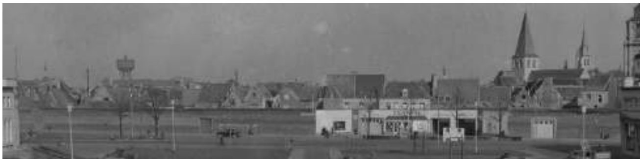
Afbeelding 47 Garage met tankstation in de Bleekweide zijde Guido Gezellelaan, de Centjesmuur werd hiertoe deels afgebroken. © Beeldbank Mechelen
